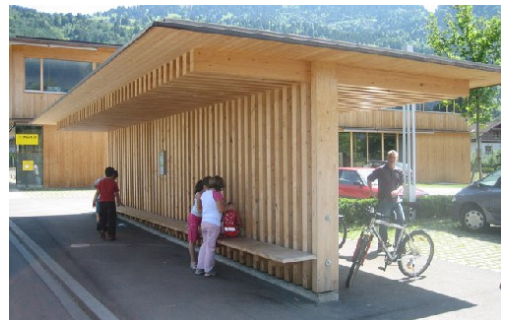
Infrastructure associant arrêt de transports publics et parc pour les deux-roues.
