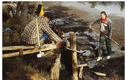
Travaux de consolidation des rives de l'étang.
