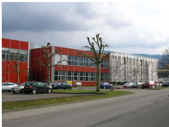
Exemple d'extension d'une construction industrielle dense sur plusieurs étages dans la zone d'activités communale de La Communance à Delémont. Photo: SAT.
