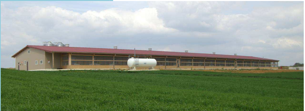
Figure 21: Poulailier, construction industrielle, tôle thermolaquée en façade Ouest, jardin d'hiver en bois et filet coupe-vent, toiture en fibrociment (Cœuve)
