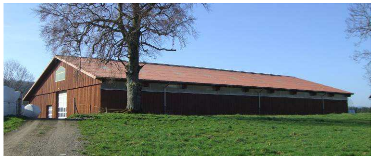
Figure 20: Volume simple, façades boisées, pignon symétrique, éclairage linéaire sous avant-toit, éternit en toiture avec plaques translucides (Le Paigre, Lajoux)
