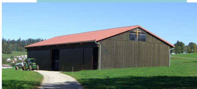
Figure 16: Construction traditionnelle, forme simple, façade pignon symétrique en bois et toiture en fibrociment (Muriaux)
