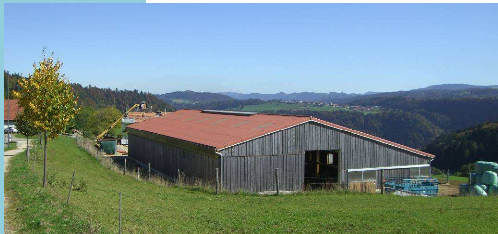
Figure 19: Saint-Brais, volume simple, orientation du faite dans le sens des courbes de niveaux et parallèle à la route, façades en bois, toiture en éternit, plaques translucides régulières en toiture, faite vitré aéré, avant-toits réduits au minimum
