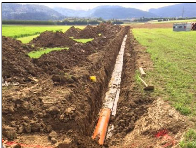
Cornol. Remplacement d'un ancien collecteur de base de drainage datant des années 1920
