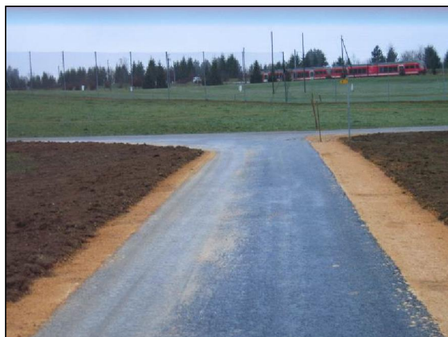
Syndicat de chemins Les Bois 2. Accès de ferme Les Murs avec suppression passage à niveau dangereux
