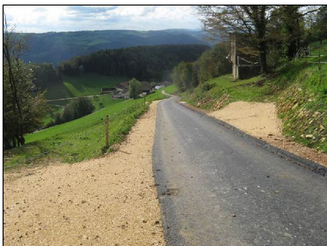
Clos du Doubs. Accès fermes Valbert avec bande pédestre RP CCM. Suite des travaux
