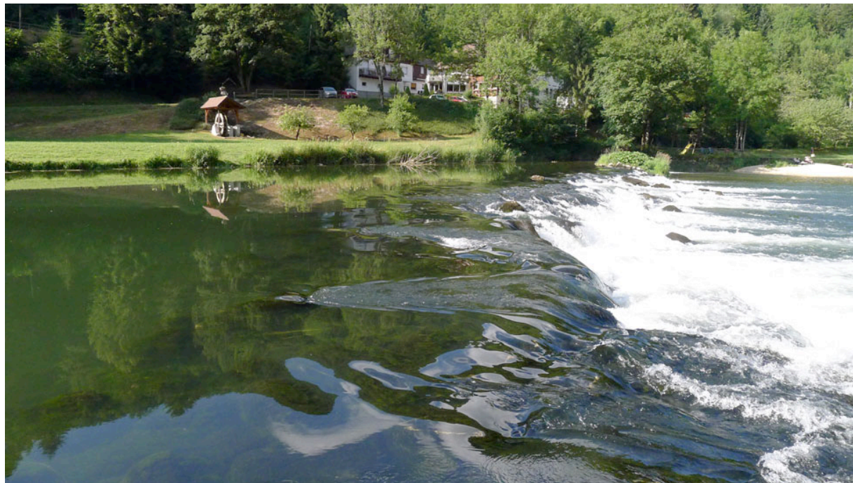
Image 7.32 Seuil en blocs au Moulin du Plain. 24.7.2013
