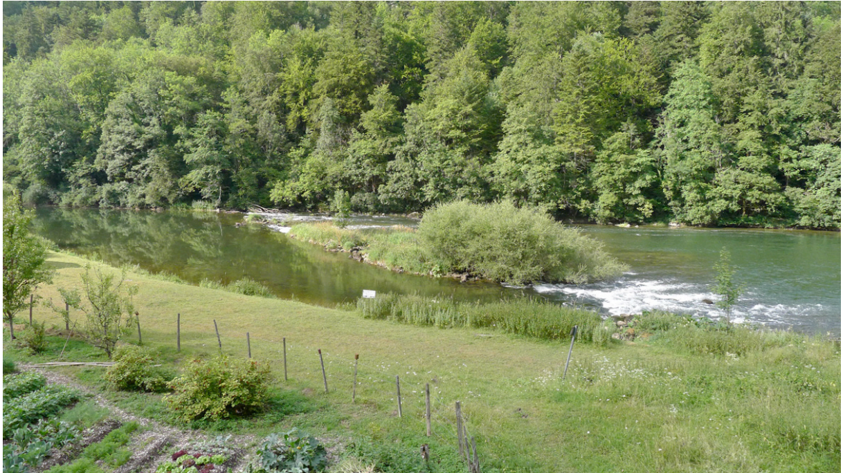
Image 7.36 Seuil à tracé oblique, partiellement remis à l'état naturel, Moulin Jeannotat. 24.7.2013
