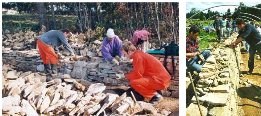
Figure 5 : Chantiers de restauration de murs de pierres sèches organisés par l'ASMPS 8
