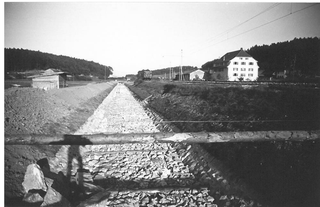
Allaine "En Roche de Mars" Porrentruy Travaux de chômage, 5 octobre 1941
