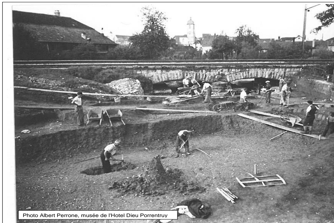
Allaine Porrentruy "En Roche de Mars" Travaux de chômage 1 er septembre 1940
