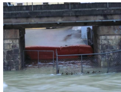
Le matériel pour lutter contre les inondations est insuffisant.
