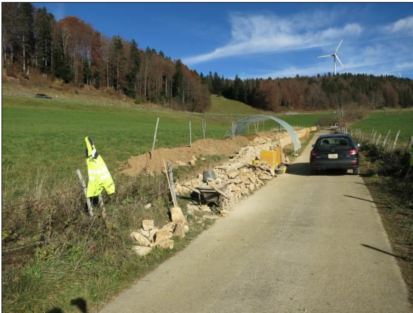
RP St-Brais. Rétablissement d'un mur en pierres sèches avec le concours de l'EFEJ à Bassecourt.
