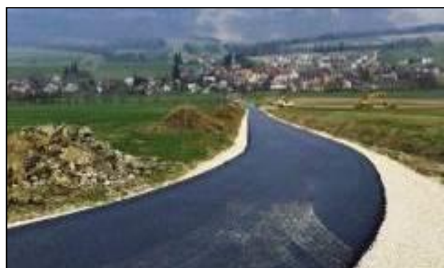
RP CCM. Derniers travaux.
