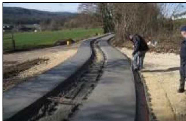
RP Rocourt. Premiers travaux.
