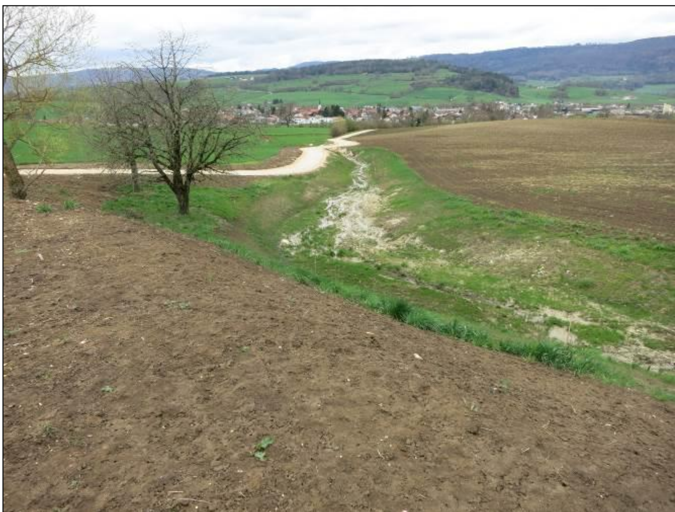
RP Courtételle. Premiers travaux.
