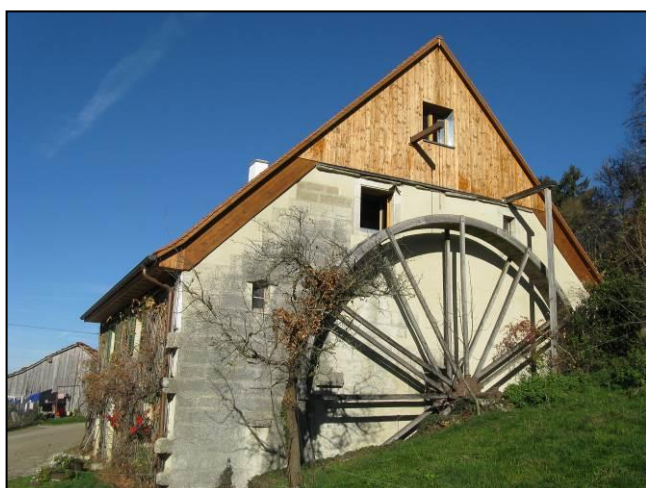
Schneider Henri, réfection et isolation du toit de la maison d'habitation, Courgenay, zone de plaine.
