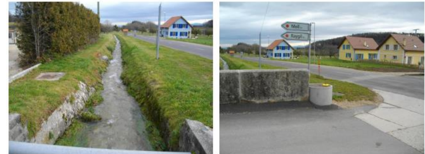
Figure 5 : (gauche) La Baumine le long de la parcelle 1147 ; (droite) vu de la parcelle 1147 depuis le ouvrage sur la Baumine le plus en aval de la localité
