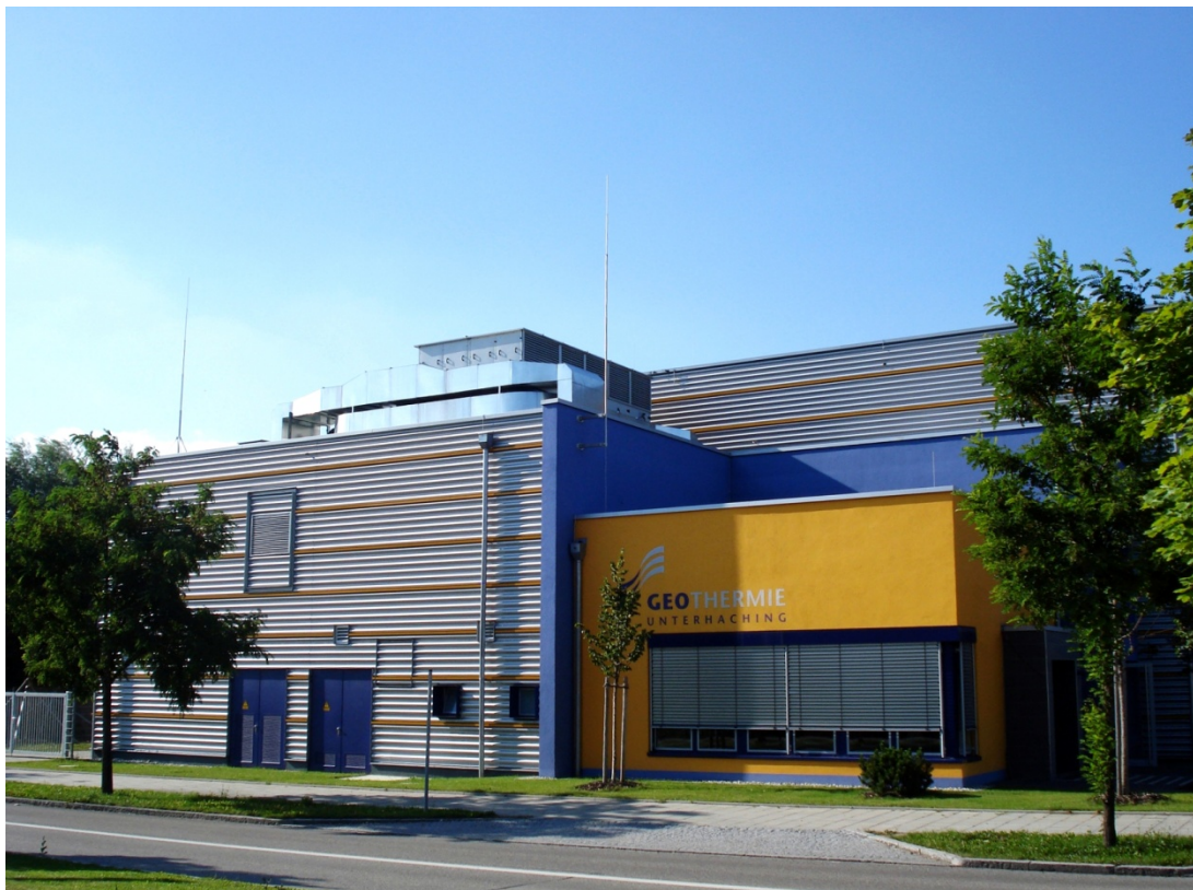
Figure 32 : Bâtiments de la centrale géothermique d'Unterhaching en Bavière (source www.geothermie-unterhaching.de )
