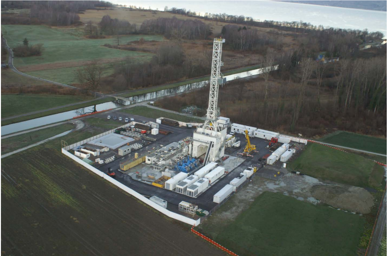
Figure 14 : Foreuse Bentec Euro Rig 350 AC (charge maximale 350 T) à Noville (VD). Exploration gazière par forage dévié, longueur totale 4298 m (Photo Daniel Willi SA)
