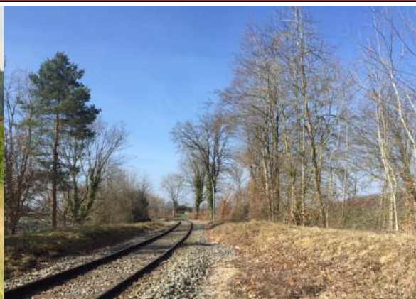
Ligne non électrifiée à Bonfol, nouvelle vocation à définir. (Source : Zbinden 2016)
