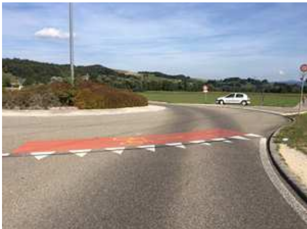
Bassecour, giratoire COOP-A16 (Photo SIN)
