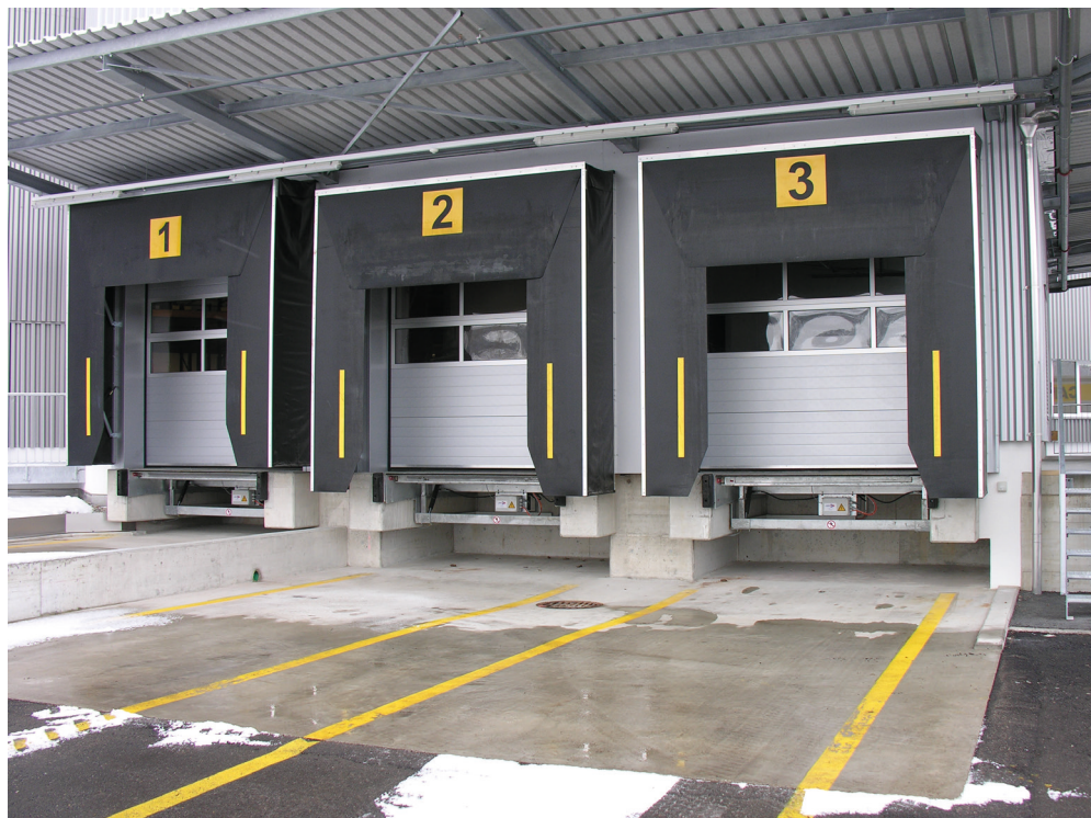
Figure 5 Place de transbordement moderne avec tunnels de chargement
