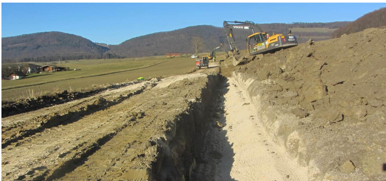
Mervelier-Corban. Conduite intercommunale eau potable SEVT (Lot A, 2 ème partie).
