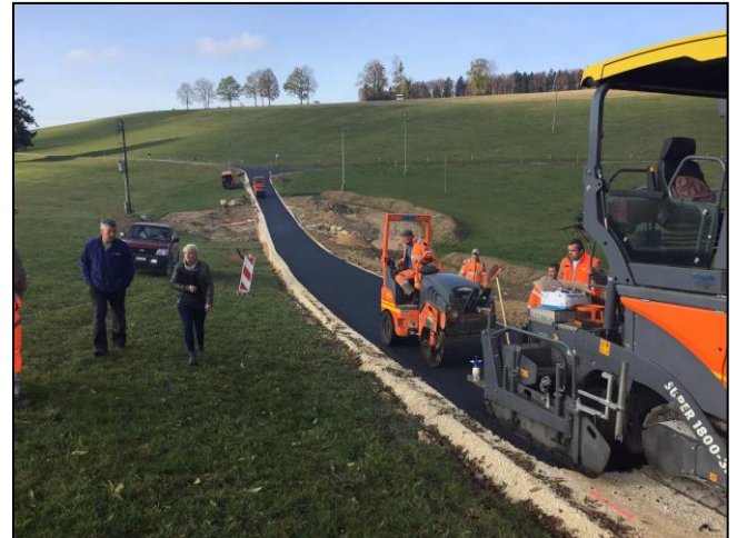
Bourrignon. Assainissement des accès de fermes.
