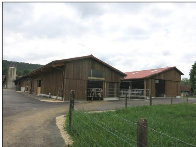
Flury Pierre, agrandissement de l'étable des vaches laitières, Courchapoix, zone des collines.
