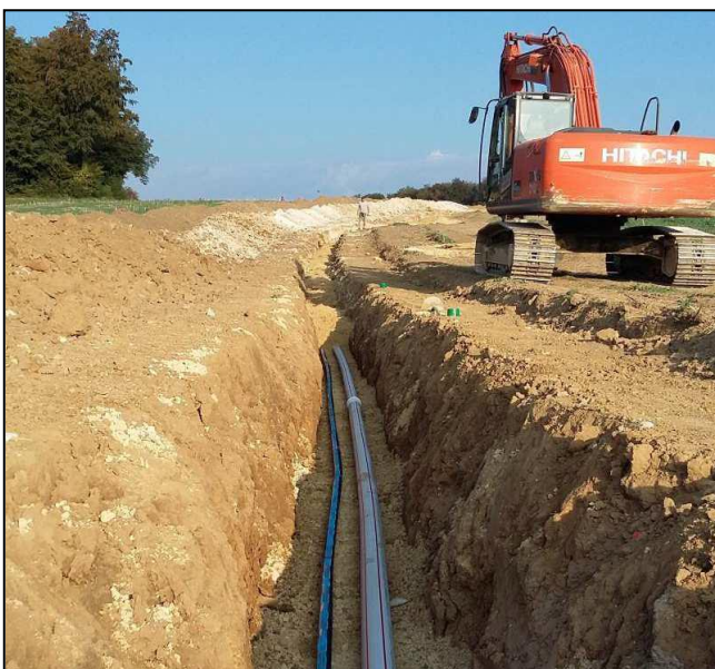
RP Grandfontaine. Viabilisation eau-électricité des colonies agricoles.
