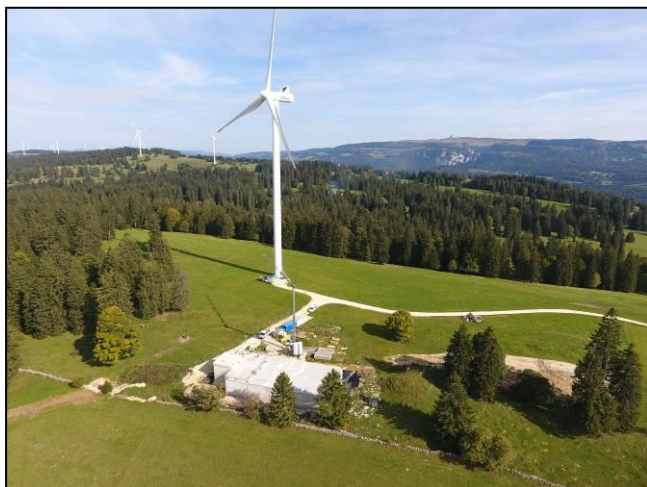
SEF III. Nouveau réservoir de La Vacherie de 2 x 750 m 3 dans les hauts de Sonvilier pour l'alimentation du secteur Ouest du SEF.
