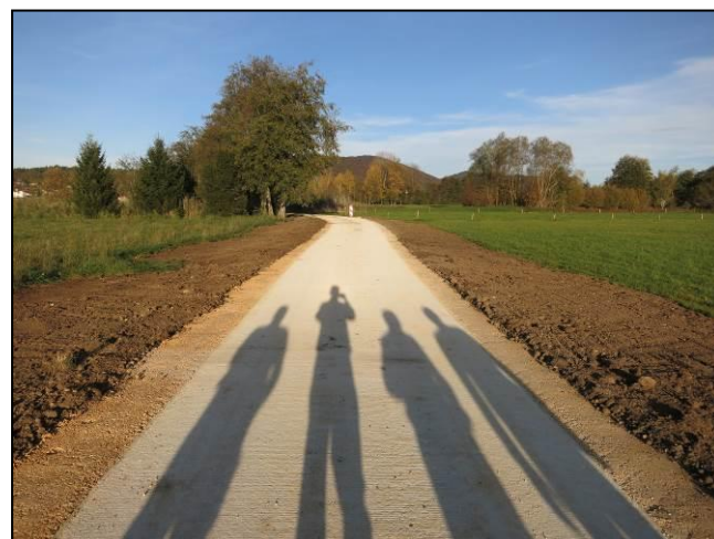
Miécourt. Derniers travaux de l'AFS, chemin du Fâtre.
