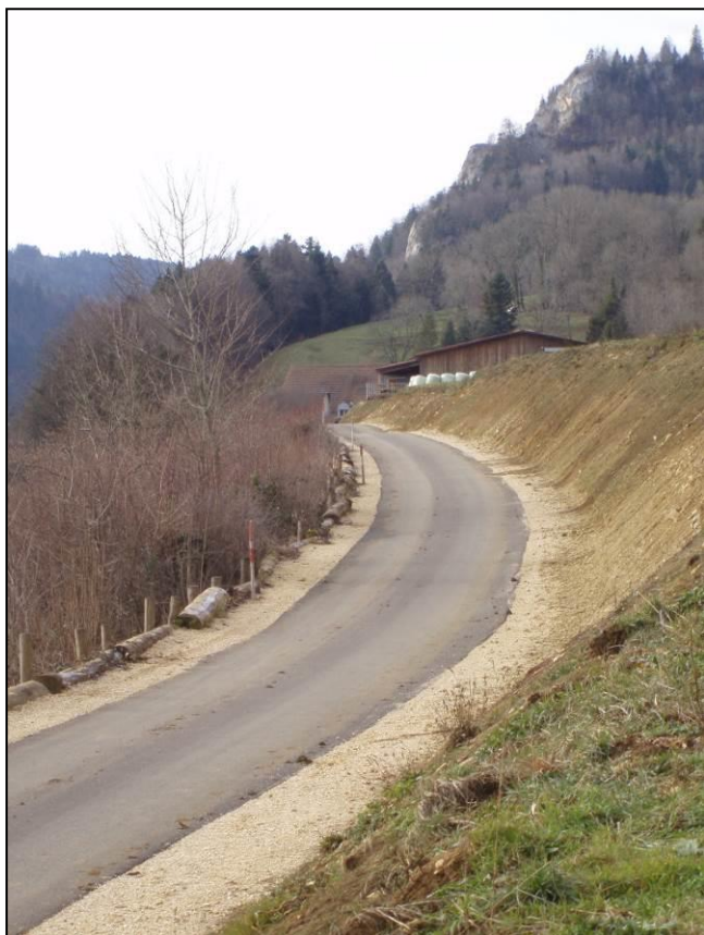
Sceut-Dessous. Accès de ferme assaini.
