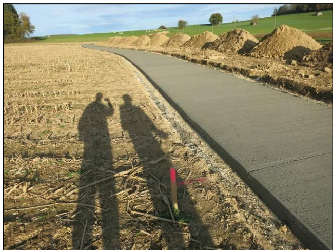
RP Dampheux. Chantier du chemin 14.
