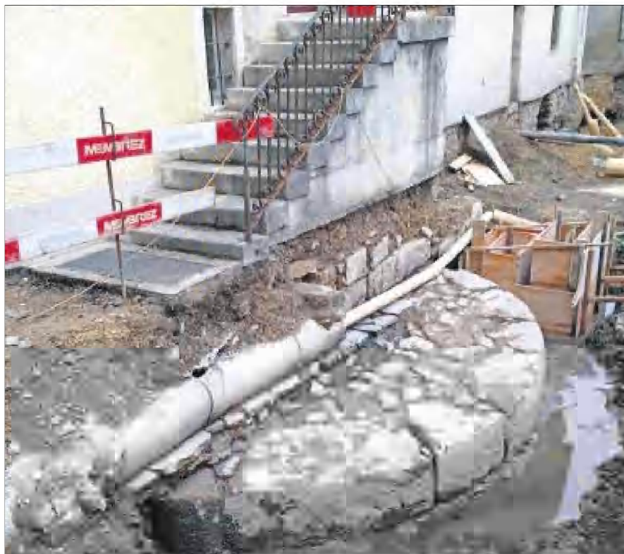
Les fondations de la tourelle datée du XV e siècle, découvertes jeudi passé derrière un immeuble de la rue du Quartier à Saint-Ursanne. Une partie restera invisible, cachée sous les escaliers du bâtiment.
