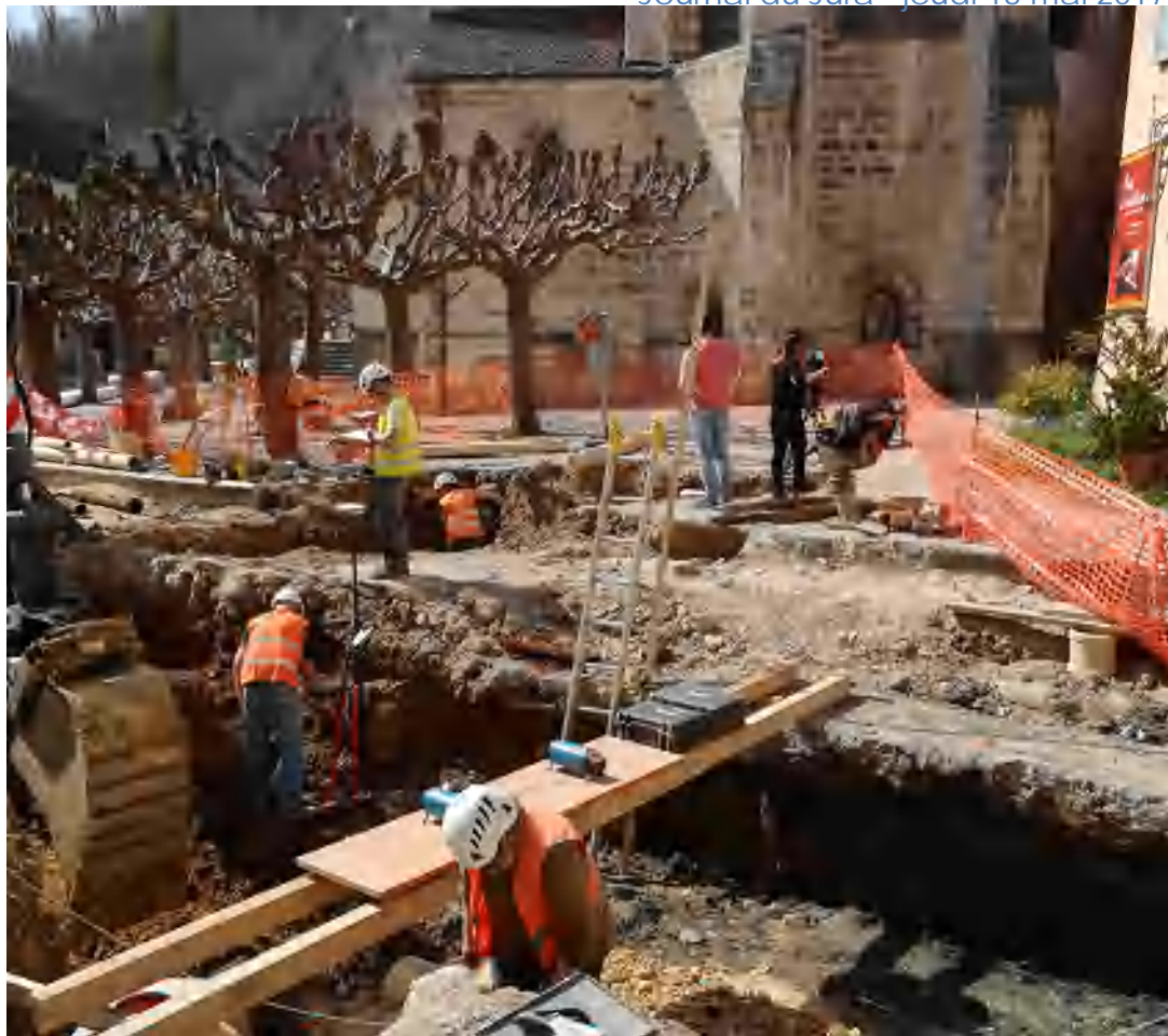
La vieille ville de Saint-Ursanne. Vue générale des travaux. OCC-SAP/LDD
