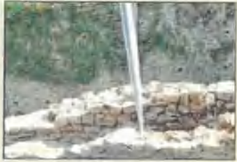
Une portion de mur de la chapelle.
