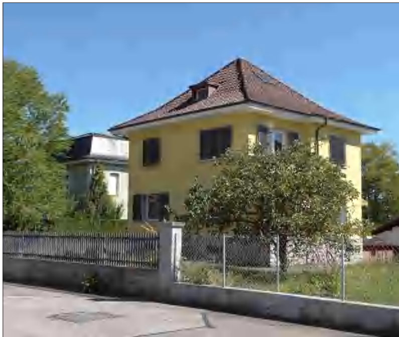
C'est à la place de ce bâtiment (la villa Marques) que sera construit le futur centre de gestion des collections de Jurassica.
