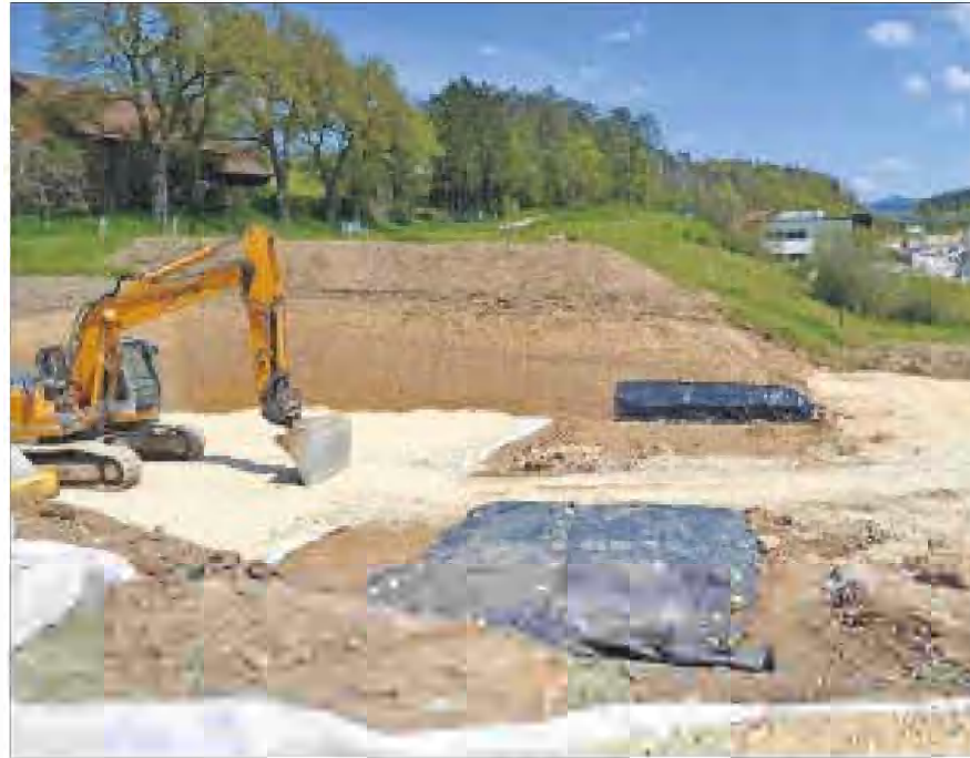
La voie romaine ici cachée sous les bâches noires, a été découverte lundi dernier sur un chantier En Roche de Mars. PHOTO AD
