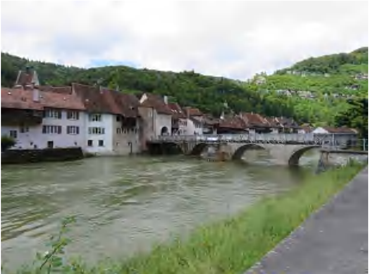
Le pont St-Jean de Saint-Ursanne en cours de rénovation.
