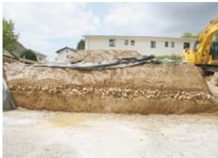
Alle, Ouches Domont: la bordure est de la route apparaît nettement dans la tranchée de construction. SP/OCC-SAP
