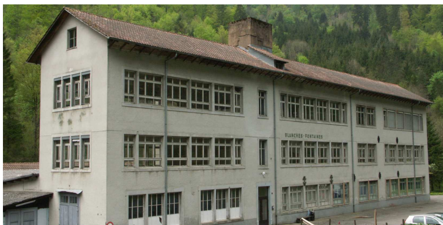
Usine Blanches-Fontaines à Undervelier
