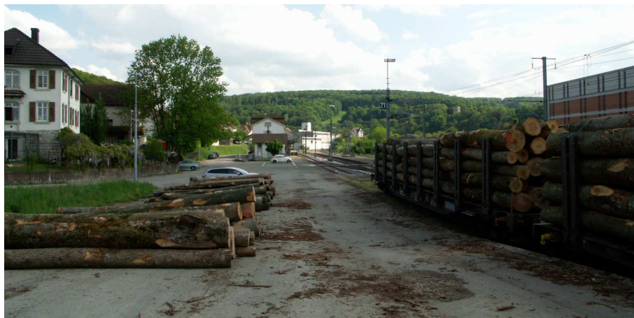
Quai de chargement des grumes à la gare de Boncourt
