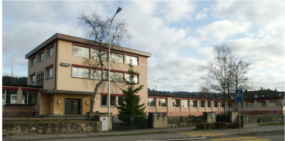
Ancienne usine Willemine à Bassecourt (6701-1069)
