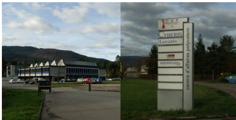
Bassecourt, usine relais
