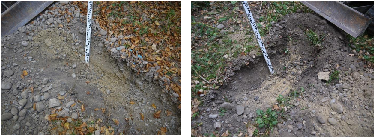
Figure 2.1 A gauche exemple de fouille sur le tronçon A et à droite exemple de fouille sur le tronçon B.
