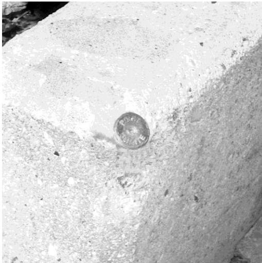
La pose d'une cheville dans un angle de mur n'est pas nécessaire si l'angle de mur est suffisamment franc. Une marque de peinture peut éventuellement souligner l'angle.
