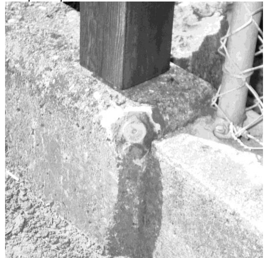
La pose d'une cheville dans un angle de mur n'est pas nécessaire si l'angle de mur est suffisamment franc. Une marque de peinture peut éventuellement souligner l'angle.
