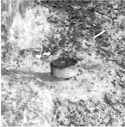
Mauvaise matérialisation : le dessus de la cheville doit être à fleur du bitume
