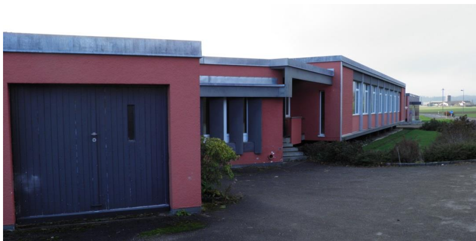
Site d'une surface inférieure à 3'000m 2 ne figurant pas dans l'inventaire initial (6794 281)
