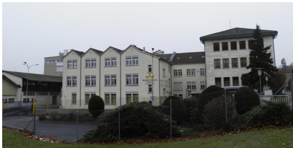
Boncourt – BAT, bâtiment Route de France 17, partiellement occupé selon la commune (6774 164)
