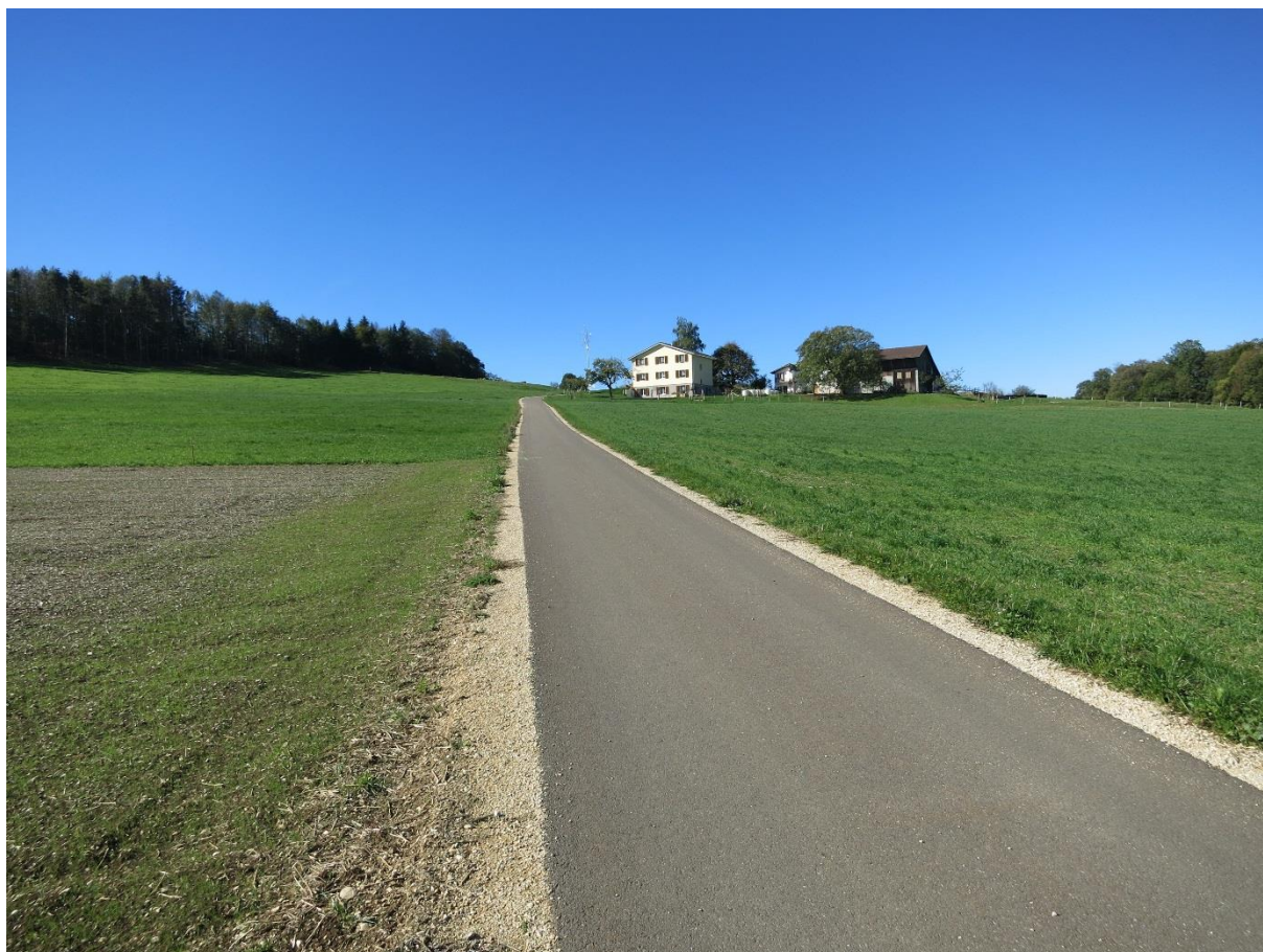
Photo 7 : Bourrignon, réfection des accès de fermes réalisées à la fin des années 1970
