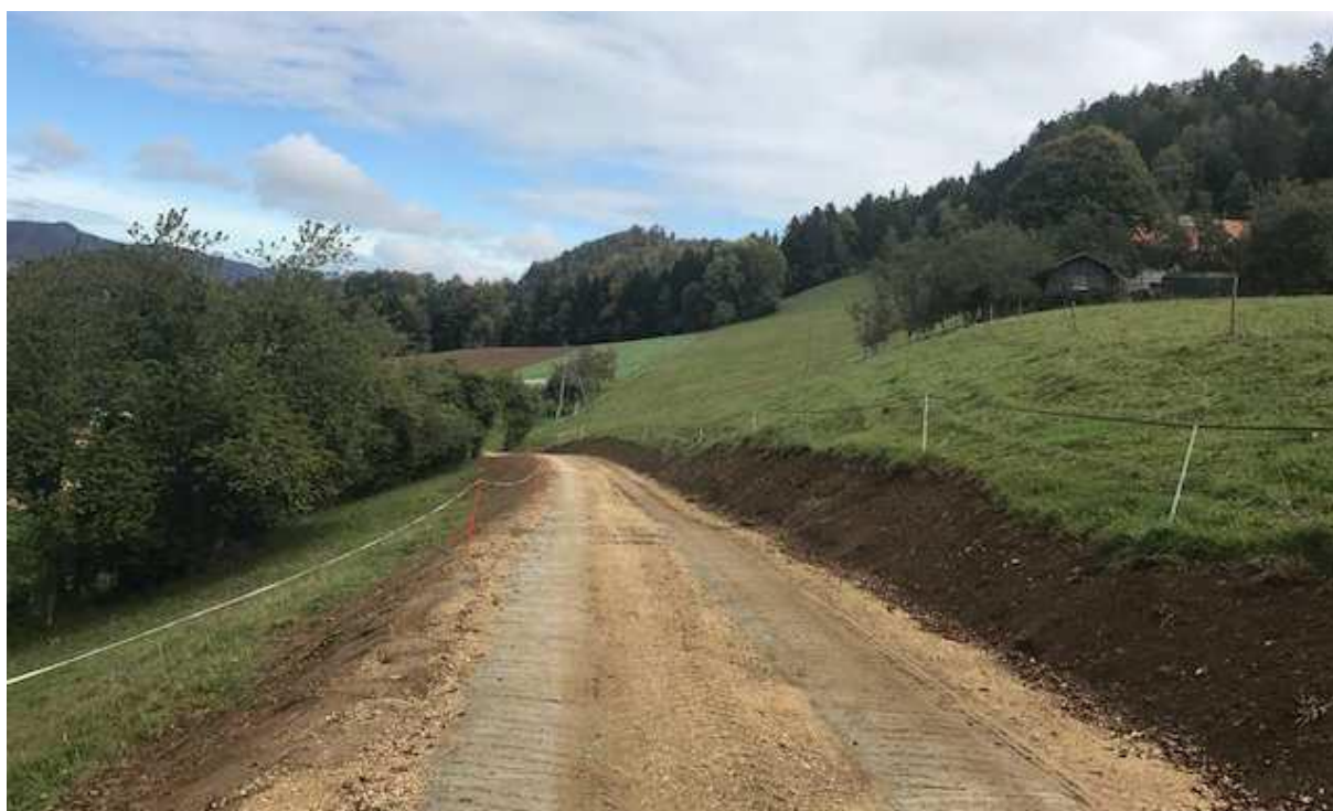
Photo 8 : Les Bois, chantier de la 2 e étape du SCB2
