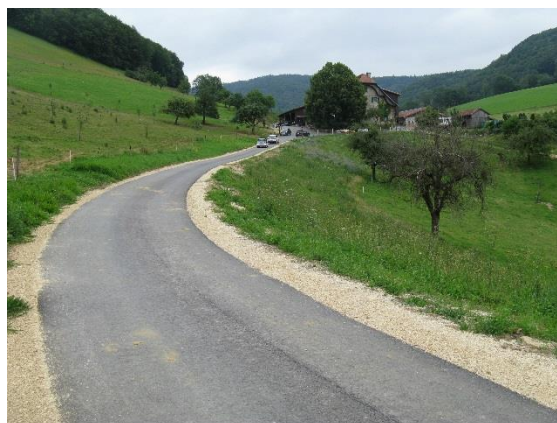
Photo 4 : Courroux, goudronnage de l'accès à la ferme de Rohrberg
