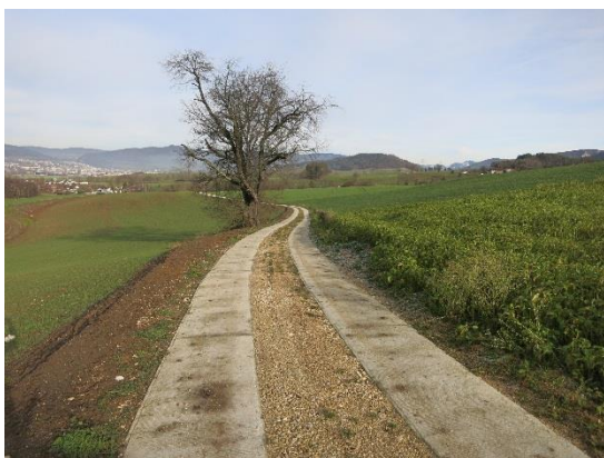
Photo 5 : 2 e étape des travaux
