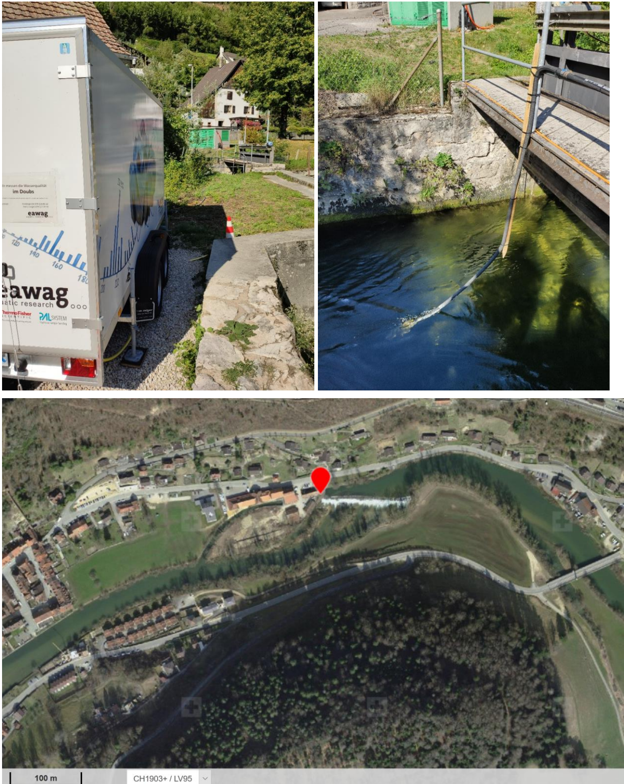
Abbildung 2: Platzierung des MS 2 field Messanhängers (Bild links oben) in St Ursanne (Bild unten, 47.36660, 7.16095 (WGS 84, lat/lon), Karte: CNES, Spot Image, swisstopo, NPOC, BAFU + Kanton, public.geo.admin.ch). Der Probenahmeschlauch wurde direkt im Überlaufkanal des Wasserfalls verankert (Bild rechts oben).
