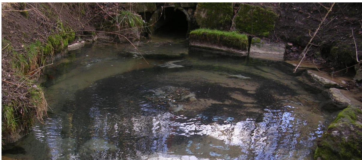
Figure 4 Exemple de rejet : Les eaux claires issues de la source de la Vendline ont un impact important (odeur, nombreux déchets) sur le cours d'eau du fait de faux raccordements dans le village de Vendlincourt.
