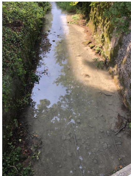
Figure 3 Colmatage du lit du Ticle par l'écoulement d'eau turbide du chantier du Théâtre du Jura.
