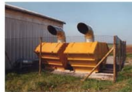
Abbildung 29: AK-Container für Abluftreinigung Zülke Umwelttechnik
