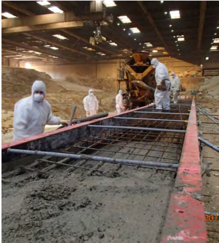
Bétonnage de la nouvelle fondation Sud
