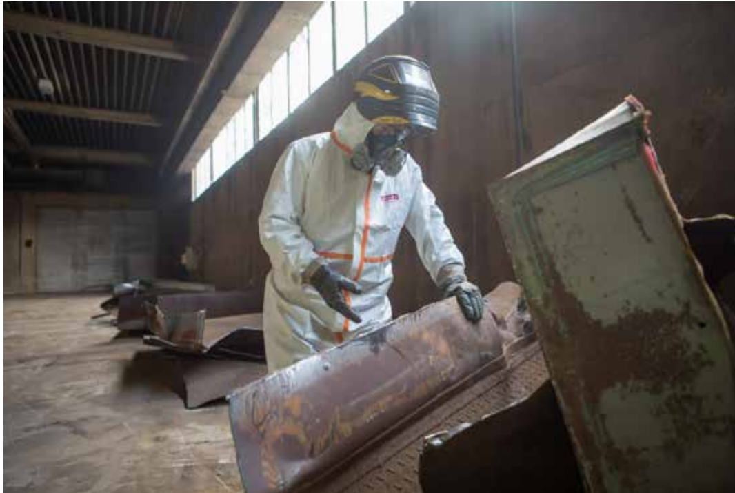
Janvier 2017: Démontage tôle d'acier dans la halle de préparation
