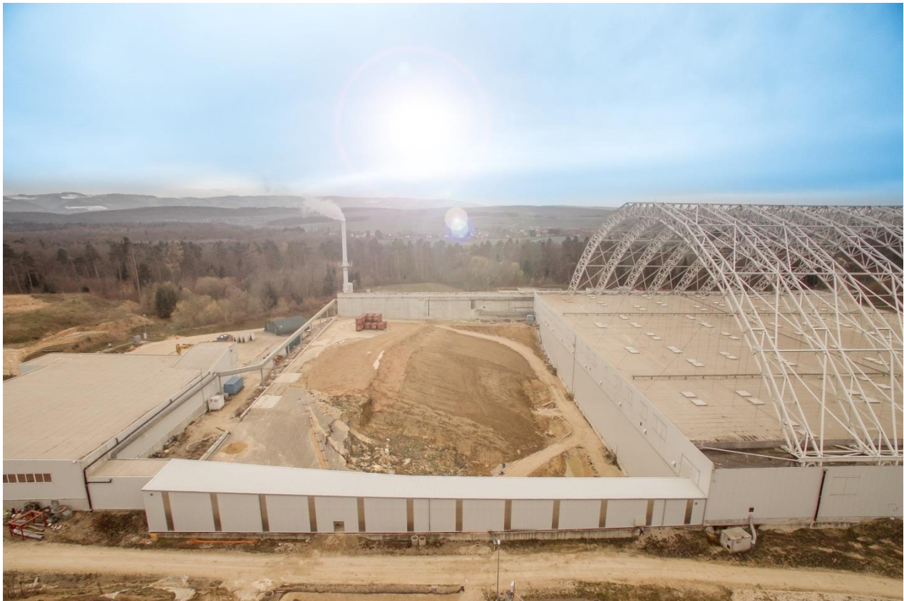
Novembre 2015 : vue aérienne de la partie sud après remblayage partiel
