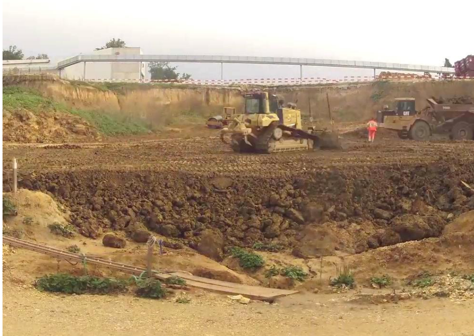
Septembre 2015 : Début des travaux de remblayage partiel de la fouille sud
