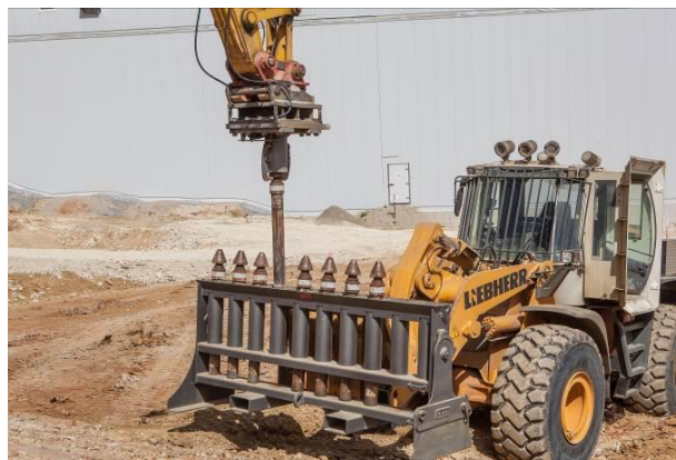
Mai 2014 : échantillonnage pour analyse de contrôle, sur les dernières parcelles de l'encaissant de la partie sud, consécutivement au décapage réalisé au préalable.
