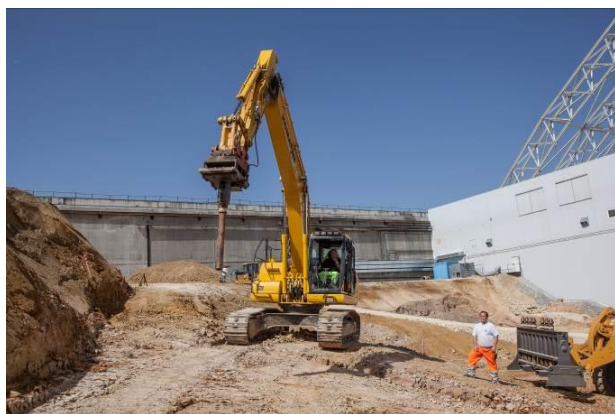
Mai 2014 : échantillonnage pour analyse de contrôle, sur les dernières parcelles de l'encaissant de la partie sud, consécutivement au décapage réalisé au préalable.
