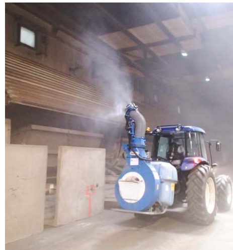
Brumisation du produit neutralisant les odeurs sur les surfaces intérieures de la halle d'excavation encore fermée au moyen d'un tracteur avec canon.
