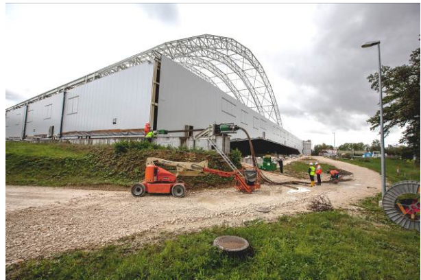
L'autre vérin hydraulique est installé sur la fondation de l'axe est. Une coordination précise entre les deux axes est primordiale lors de la traction de la structure.
