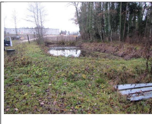
Figure 5.5 Étang DIB avant travaux.
