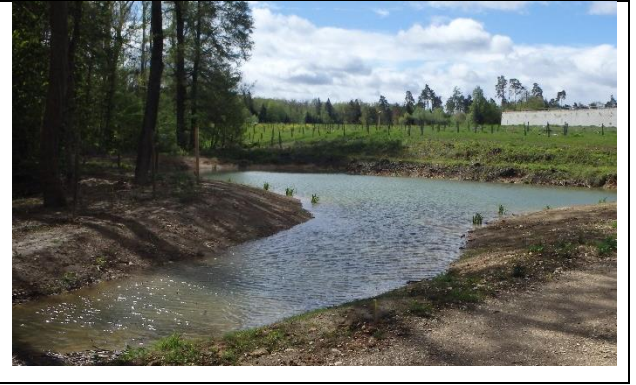
Figure 5.8 Berge nord terrassée en pente douce et agrandissement
