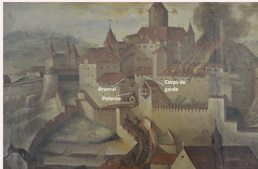
Fig. 10. Détail du tableau de l'incendie du château en 1697. (Huile sur toile se trouvant au premier étage du Tribunal cantonal, 84 x 158 cm)
