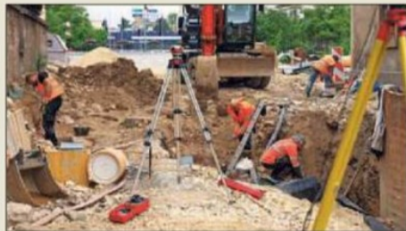
À la rue Joseph-Trouillat, les secteurs qui renferment un rempart et la fondation d'une tour ont été rebouchés, mais on a trouvé des murs. PHOTO MN
