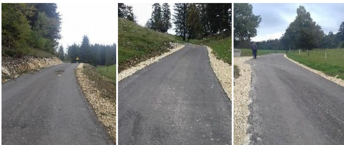
Photos 5-7 : Etat après travaux (accès de Montcenez)
