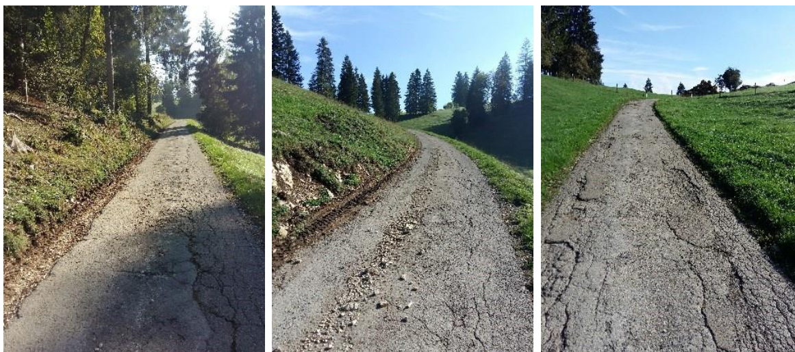
Photos 2-4 : Etat avant travaux (accès de Montcenez)
