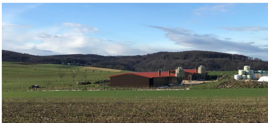
Photo 1 : Alimentation en eau et électricité de 2 poulaillers à Montignez
