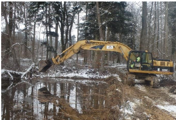
Figure 6.27 Curage depuis la rive.
