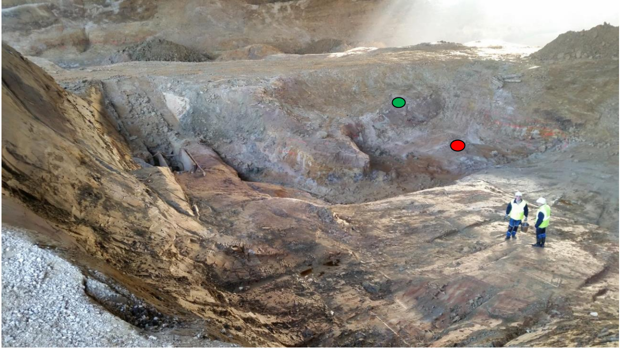
Figure 4 : Photos du fond de l'excavation avant remblayage indiquant les emplacements approximatifs de FO102 : initialement prévu (point rouge) et final (point vert).
