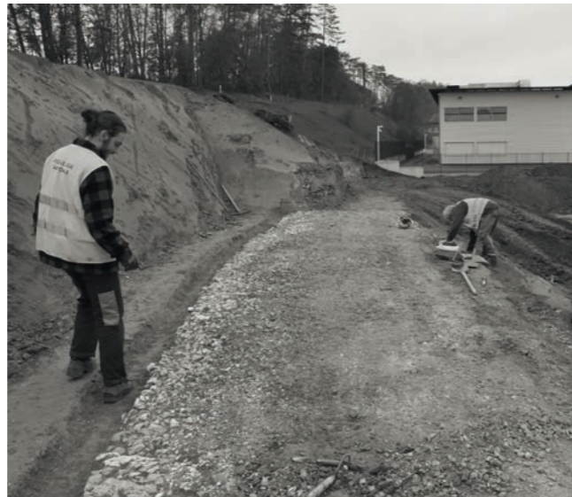
Porrentruy-En Roche de Mars. Dégagement de la voie gallo-romaine, le 11 novembre.
