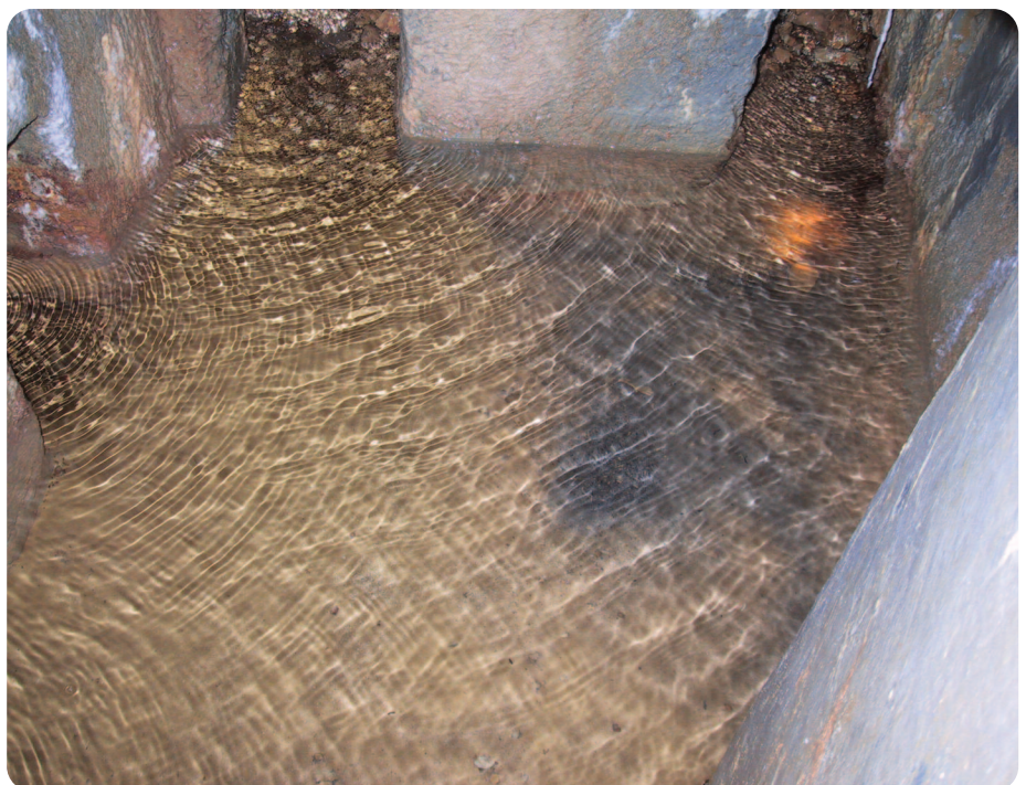
Source karstique captée pour l'alimentation en eau potable
