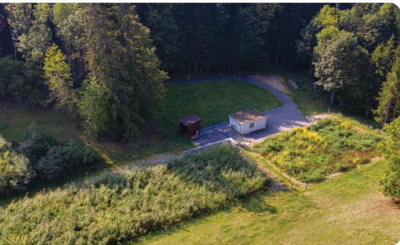
La SNEP de Saulcy est, comme son nom l'indique, une station naturelle d'épuration des eaux. Les eaux usées y sont épurées naturellement dans des bassins plantés de roseaux. Cette technique est souvent adaptée aux petites localités.
