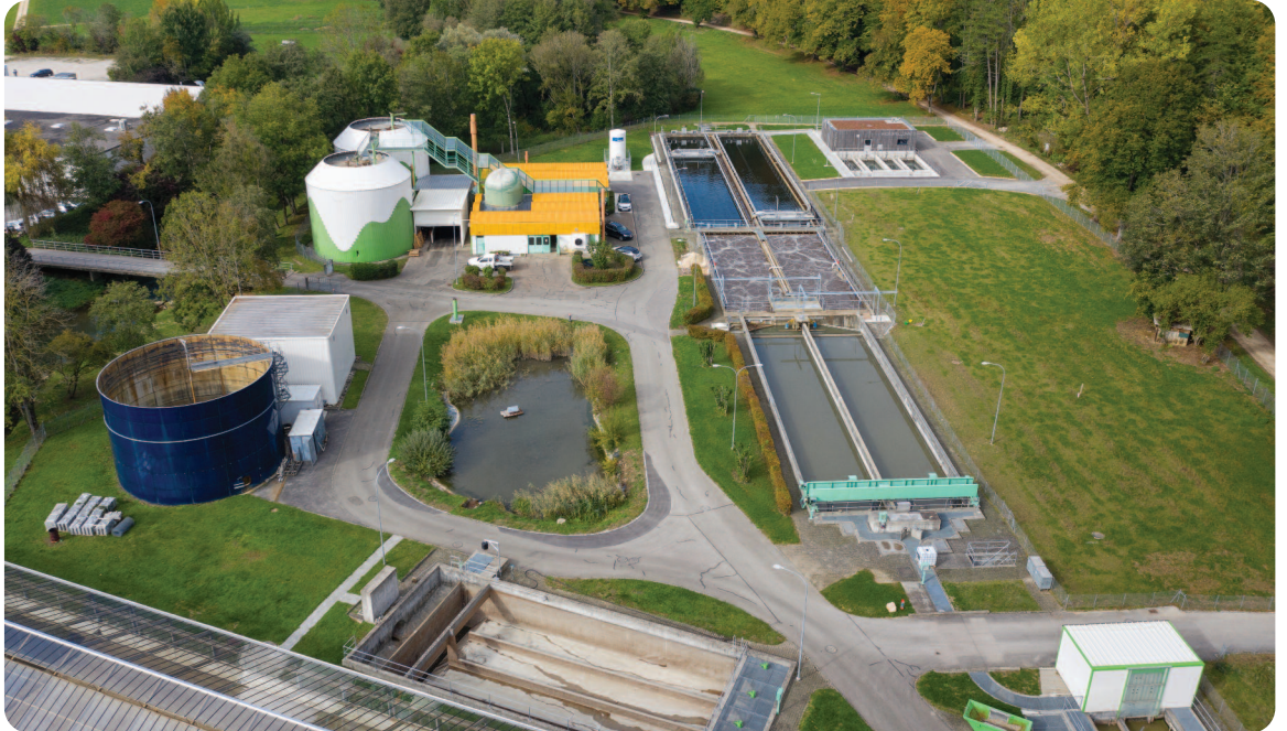
Exemple de station d'épuration des eaux (Porrentruy)
