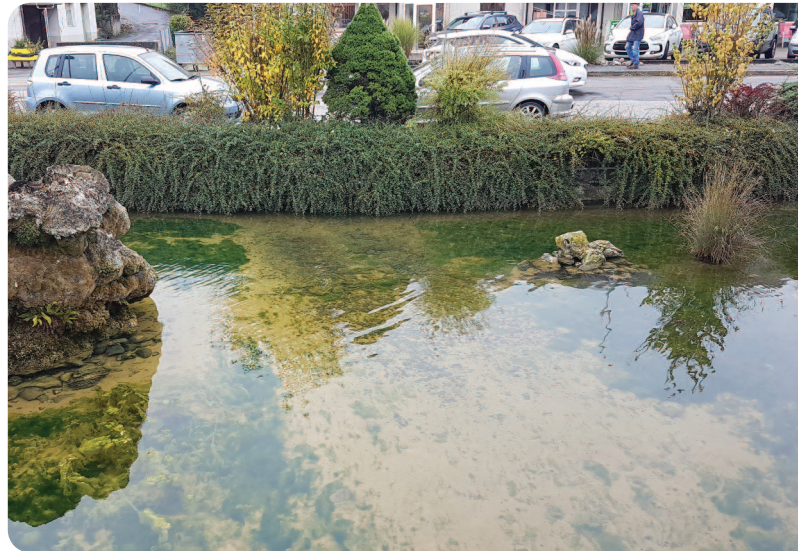
Certaines sources fortement artificialisées recèlent un potentiel important de revitalisation (Bonne-Fontaine à Fontenais).
