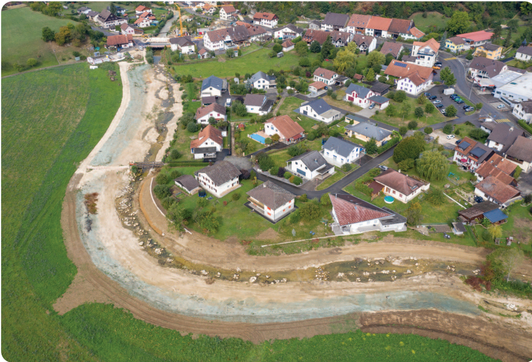
Chantier en cours de réaménagement de la Scheulte à Reclaine.
