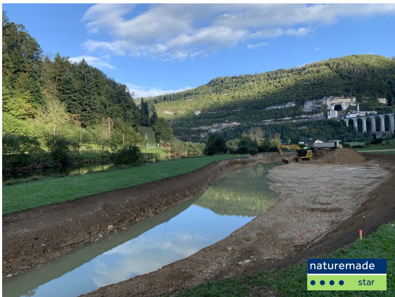
Photo du bras mort en terrassement vue depuis le côté Sud (Source : Stève Guerne, ENV - 29.09.2021)
