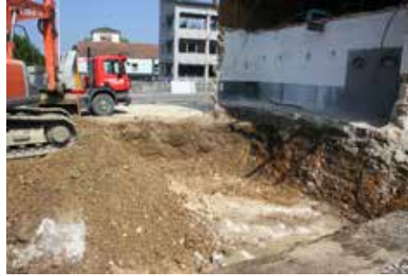
Fig. 2.168 (à gauche) Porrentruy – Dépôts Warteck. Le dépôt Warteck à moitié déconstruit vu depuis l'ouest. Photo P.-A. Borgeaud, OCC-SAP
