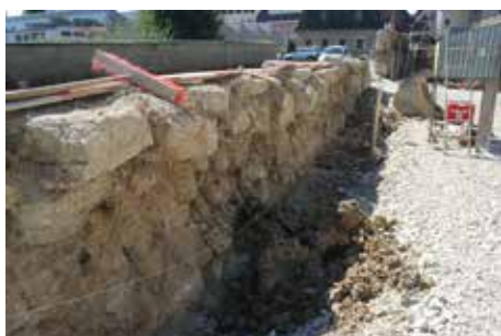
Fig. 2.201 (à gauche) Porrentruy – Cras Mouche. Vue de la face arrière du mur de soutènement longeant la route. Photo P.-A. Borgeaud, OCC-SAP
