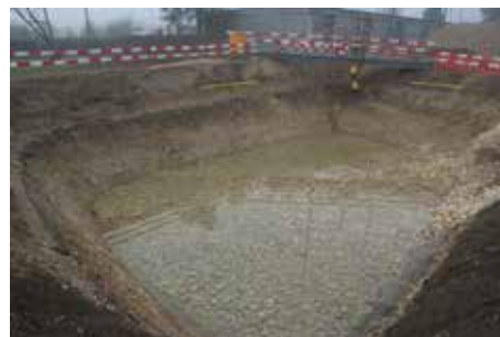
Fig. 2.38 (à gauche) Bassecourt – Entre les Vies. Le grand terrassement vu depuis l'ouest. Photo P.-A. Borgeaud, OCC-SAP
