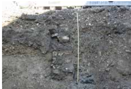
Fig. 2.170 (à gauche) Porrentruy – Dépôts Warteck. Début du terrassement profond de la fosse à citernes. On aper- çoit le mur de la cave à droite. Photo P.-A. Borgeaud, OCC-SAP
