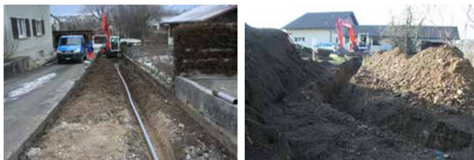
Fig. 2.220 (à gauche) Vicques – route de Courroux. Vue de la conduite électrique depuis le sud. Photo P.-A. Borgeaud, OCC-SAP
