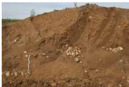
Fig. 2.155 (à gauche) Porrentruy – Sous Roche de Mars. La coupe occidentale 1 avant la poursuite du terrassement mécanique. Photo P.-A. Borgeaud, OCC-SAP
