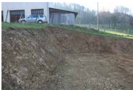
Fig. 2.61 (à gauche) Cornol – Ferme de Monneri. Vue de la coupe dans l'angle sud-ouest du terrassement. Photo P.-A. Borgeaud, OCC-SAP
