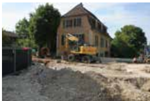
Fig. 2.193 Porrentruy – rue du Gravier. Les travaux en cours vus depuis le nord-est. Photo P.-A. Borgeaud, OCC-SAP
