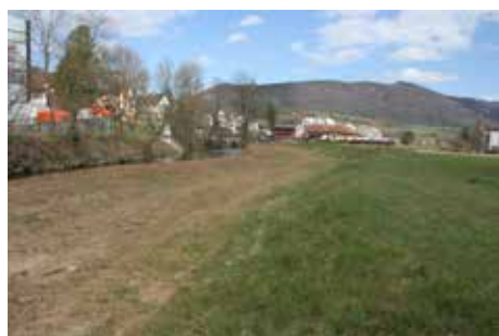
Fig. 2.100 (à gauche) Delémont – Gros-Seuc. La digue (en herbe à droite) vue depuis le sud-ouest. Photo P.-A. Borgeaud, OCC-SAP
