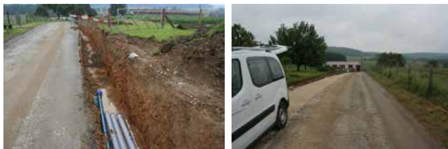
Fig. 2.141 (à droite) Montignez – Route du Canada. Vue en direction du nord avec la tran- chée de canalisations fraîchement rebouchée et en arrière-plan le rural du Canada. Photo P.-A. Borgeaud, OCC-SAP
