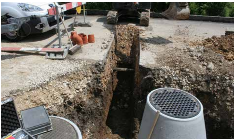
Fig. 2.77 Courroux – Rue des Romains. La tranchée de raccordement sous la route. Photo P.-A. Borgeaud, OCC-SAP
