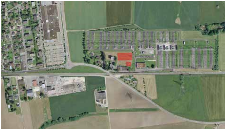
Fig. 2.37 Bassecourt – Entre les Vies. Situation de la station transformatrice BKW et de deux surfaces fraîchement excavées (en rouge). Orthophoto tirée du GéoPortail jura.ch
