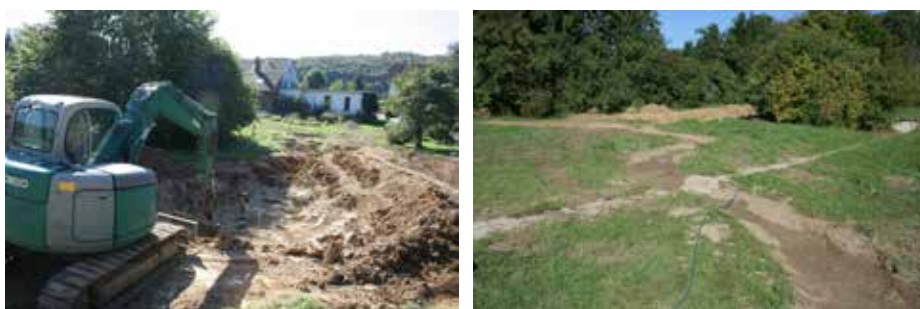
Fig. 2.97 (à gauche) Damvant – Champ des Planches. Le terrassement de l'étang-biotopie vu depuis le nord. Photo P.-A. Borgeaud, OCC-SAP
