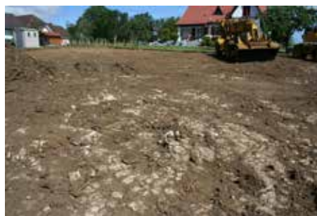
Fig. 2.132 (à gauche) Grandfontaine – Rue des Lilas. La parcelle après le décapage de la terre végétale, vue depuis le nord-est. Photo P.-A. Borgeaud, OCC-SAP
