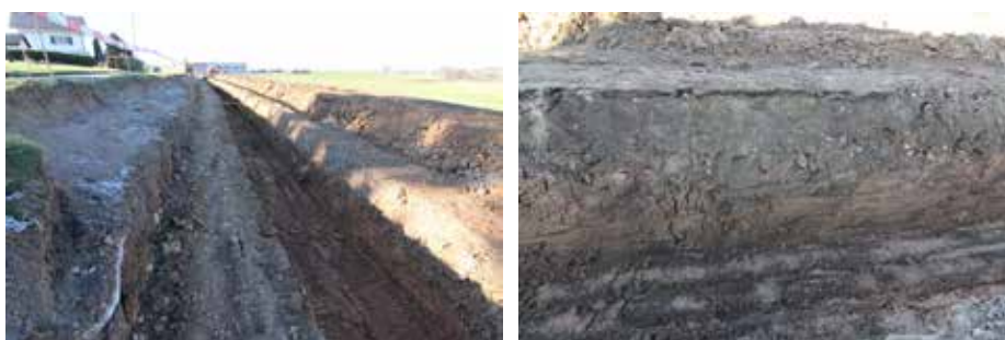
Fig. 2.45 (à gauche) Charmoille – Pré Carré. La tranchée principale vue depuis l'est. Photo P.-A. Borgeaud, OCC-SAP
