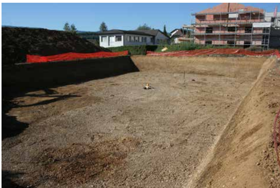
Fig. 2.11 Alle - Route de Porrentruy. Vue du terrassement profond en direction du sud-ouest. En arrière-plan, on voit l'immeuble en construction sous lequel a été observée et documentée une voie (via privata) qui desservait probablement la villa romaine de Alle. Photo P.-A. Borgeaud, OCC-SAP
