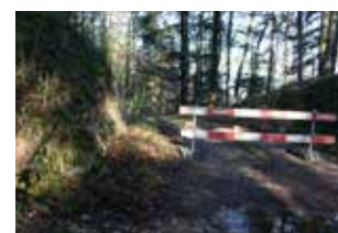
Fig. 2.26 Asuel – Le Chételat. Le défilé au sommet du Chételat barré pour les travaux et vu depuis l'est. Photo P.-A. Borgeaud, OCC-SAP
