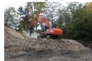
Fig. 2.143 Pleigne – Ziegelkopf. La carrière en cours d'exploitation vue depuis l'ouest. Photo P.-A. Borgeaud, OCC-SAP
