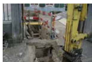
Fig. 2.180 Porrentruy – Thermoréseau. La tranchée de raccordement du bâtiment n°6 au Faubourg de France. Photo P.-A. Borgeaud, OCC-SAP
