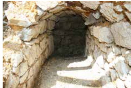
Fig. 2.184 (à gauche) Porrentruy – Thermoréseau. Vue de l'ancienne conduite éventrée par les travaux à la croisée de la Ruelle de la Cigogne. Photo P.-A. Borgeaud, OCC-SAP
