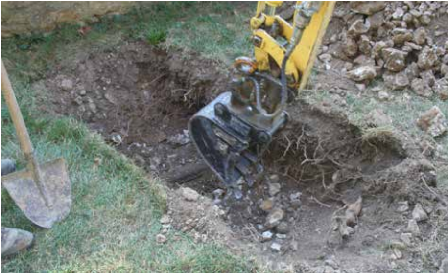
Fig. 2.149 Porrentruy – Parc Mouche/Le Château. Vue de la petite tranchée pour l'installation du pousse-tube. Photo P.-A. Borgeaud, OCC-SAP
