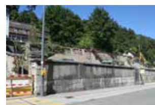
Fig. 2.197 Porrentruy – Cras Mouche. Le chantier vu depuis le sud. Photo P.-A. Borgeaud, OCC-SAP
