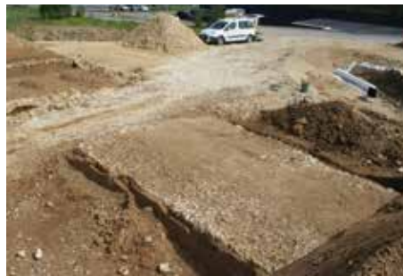
Fig. 2.162 (à gauche) Porrentruy – Sous Roche de Mars. Nettoyage manuel de la partie occidentale de la voie. Photo P.-A. Borgeaud, OCC-SAP
