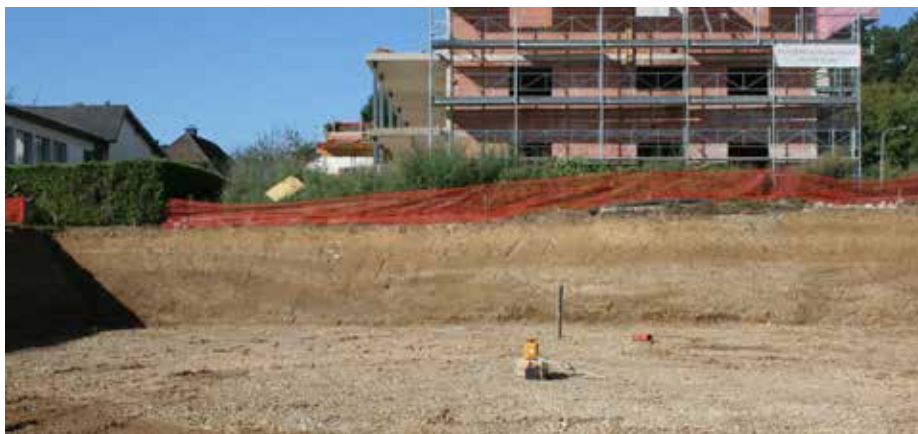
Fig. 2.12 Alle - Route de Porrentruy. Vue de la coupe à l'ouest du terrassement profond. Photo P.-A. Borgeaud, OCC-SAP
