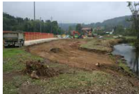
Fig. 2.55 (à gauche) Courchavon – Le Gros Gravier. Vue depuis le sud-ouest, de la piste et de la zone de chantier sur la parcelle 78. Photo P.-A. Borgeaud, OCC-SAP
