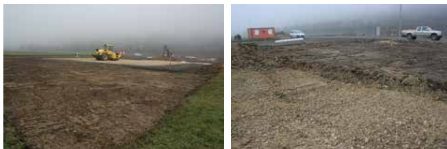
Fig. 2.42 (à gauche) Bassecourt – Zone industrielle La surface terrassée vue depuis le sud-est. Photo P.-A. Borgeaud, OCC-SAP
