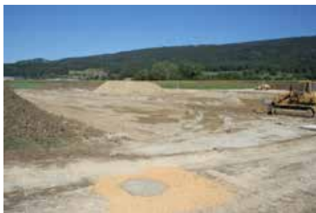
Fig. 2.106 (à gauche) Delémont – Pré au Loup. La surface des travaux vue depuis le sud-est. Photo P.-A. Borgeaud, OCC-SAP
