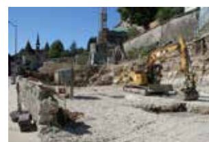
Fig. 2.198 Porrentruy – Cras Mouche. Le terrassement vu depuis l'est. Photo P.-A. Borgeaud, OCC-SAP
