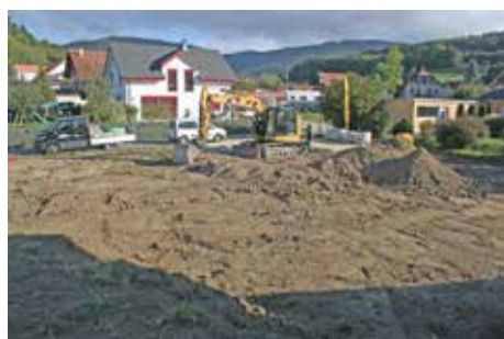
Fig. 2.223 (à gauche) Vicques – Es Monte. Le terrassement vu depuis le sud-ouest. Photo P.-A. Borgeaud, OCC-SAP
