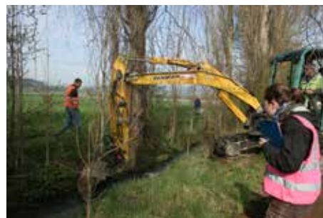
Fig. 2.84 (à gauche) Courroux – Canal de Bellevie. Vue du creusage d'un sondage. Photo P.-A. Borgeaud, OCC-SAP
