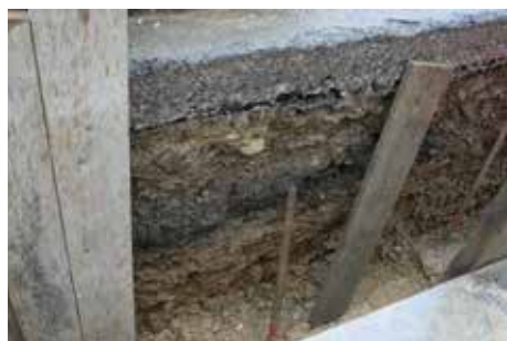
Fig. 2.178 (à gauche) Porrentruy – Thermoréseau. Vue partielle de la coupe sud dans la tranchée du collecteur principal, vis-à-vis du bâtiment n°4 à la route de Bure. Photo P.-A. Borgeaud, OCC-SAP
