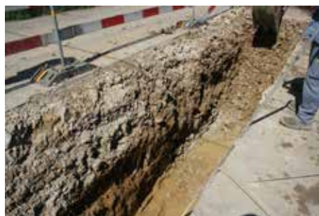
Fig. 2.135 (à gauche) Montignez – Route du Canada. Vue en direction du nord de la tranchée du collecteur principal d'égouts dans le village (à proximité de la croisée avec la route de Lugnez). Photo P.-A. Borgeaud, OCC-SAP
