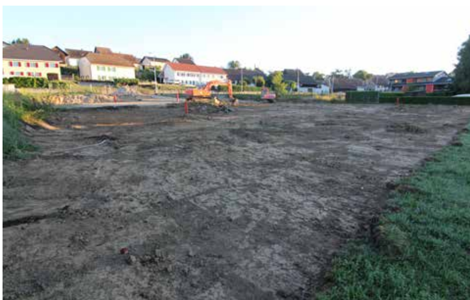
Fig. 2.10 Alle - Route de Porrentruy. Vue en direction du nord après l'enlèvement de la terre végétale. Photo P.-A. Borgeaud, OCC-SAP
