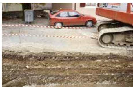
Fig. 3.3 (à gauche) Porrentruy – Hôtel-Dieu. Les couches archéologiques dans la tranchée prospective nord-sud. Photo P.-A. Borgeaud, OCC-SAP
