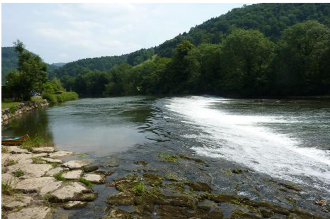
Seuil du Moulin du Doubs à Ocourt. Barrage d'une hauteur de 2 m et d'une largeur de 90 m totalement infranchissable pour l'apron.
