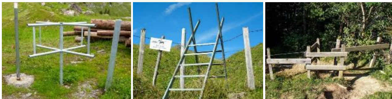
figure 10 : Franchissements de clôture pas praticables par les VTT
