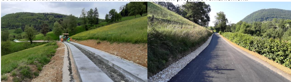
SAF Ederswiler / 1 ère étape de chantier pose des chemins en bandes de roulement et bitume
