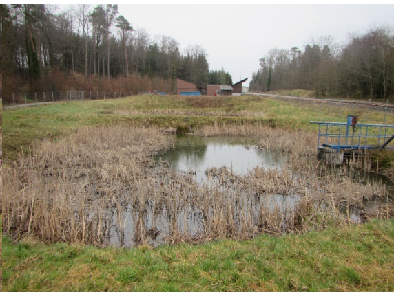
Figure 2 Étangs STEP vus depuis l'ouest
