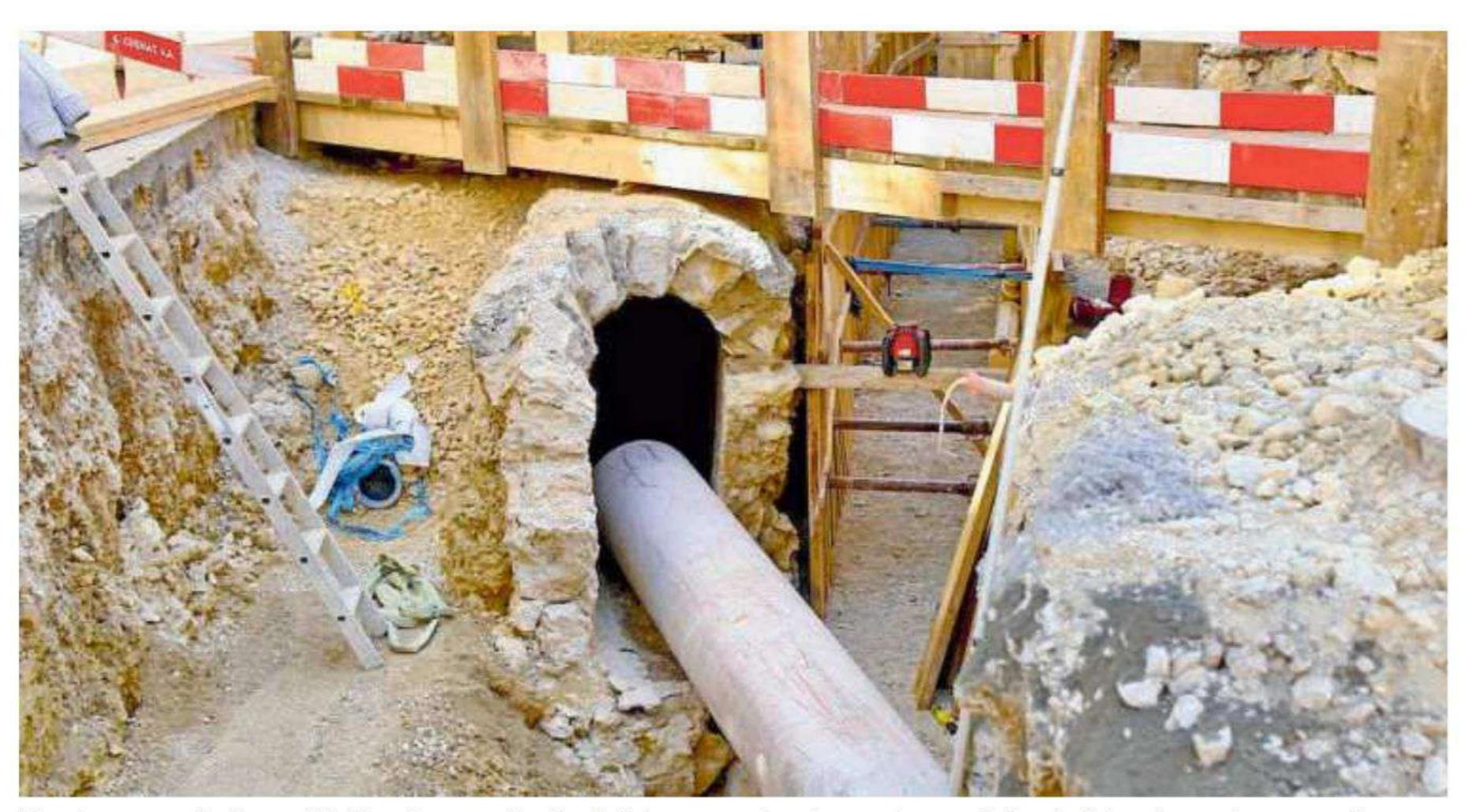
L'ancienne canalisation a été démolie en partie afin de faire passer dans la zone les conduites du futur réseau des eaux usées et du chauffage à distance.
