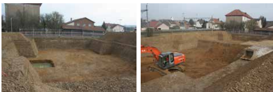
Fig. 2.9 (à gauche) Alle – Rière chez Guenat. Les terrassements profonds vus depuis le sud-ouest. Photo P.-A. Borgeaud, OCC-SAP
