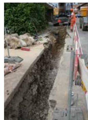
Fig. 2.158 Pleigne – Route des Geais. La tranchée vis-à-vis de la maison n°28 vue depuis l'est. Photo P.-A. Borgeaud, OCC-SAP
