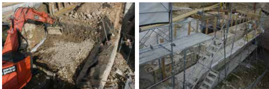
Fig. 2.329 (à gauche) Porrentruy – Château. Remblayage avec le système en terramur. Photo P.-A. Borgeaud, OCC-SAP
