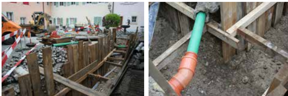
Fig. 2.201 (à droite) Porrentruy – Annonciades, Capucins, Route de Fontenais. Vue d'un bloc de fondation du mur (sous le tuyau vert), aperçu dans l'angle déjà échafaudé de la tranchée du thermoréseau dans la cour aux Capucins. Photo P.-A. Borgeaud, OCC-SAP
