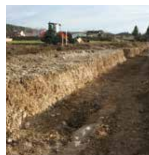
Fig. 2.21 Bassecourt – Les Longues Royes. Tranchée de canalisation vue depuis l'ouest. Photo P.-A. Borgeaud, OCC-SAP
