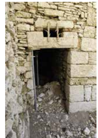
Fig. 2.314 Porrentruy – Château. Le linteau de porte avec son étau provisoire. Photo P.-A. Borgeaud, OCC-SAP
