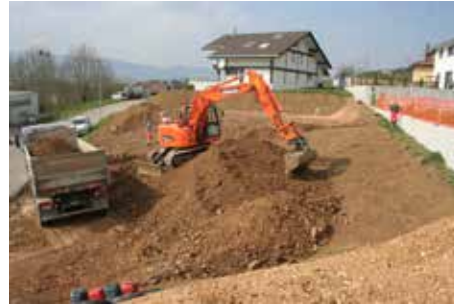
Fig. 2.104 (à gauche) Delémont – Chemin des Adelles. La parcelle 4018 en cours de terrassement vue depuis le sud. Photo P.-A. Borgeaud, OCC-SAP
