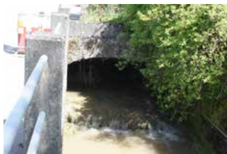
Fig. 2.92 (à gauche) Cornol – Lion d'Or. Apparition de la voûte de pierres, bord nord. Photo P.-A. Borgeaud, OCC-SAP
