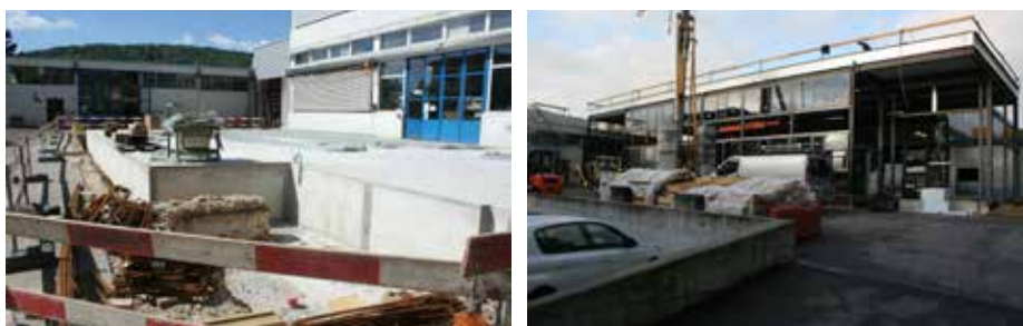
Fig. 2.143 (à gauche) Develier – rue des Romains. La nouvelle construction en cours vue depuis le nord. Photo P.-A. Borgeaud, OCC-SAP
