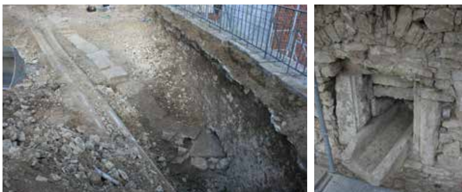
Fig. 2.253 (à gauche) Porrentruy – Château. La coulisse en pierres st. 1 vue depuis le sud-ouest. Photo P.-A. Borgeaud, OCC-SAP
