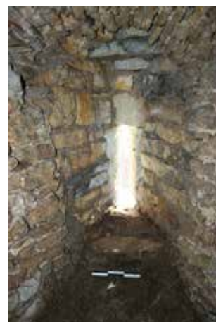
Fig. 2.319 Porrentruy – Château. La meurtrière méridionale. Photo P.-A. Borgeaud, OCC-SAP
