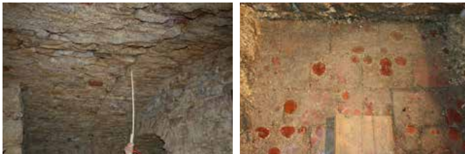
Fig. 2.327 (à gauche) Porrentruy – Château. Le plafond du corps de garde-prison. Voûte principale st. 34 à gauche et arrière- voûture st. 35 à droite (la transition est montrée avec le double-mètre). Photo P.-A. Borgeaud, OCC-SAP
