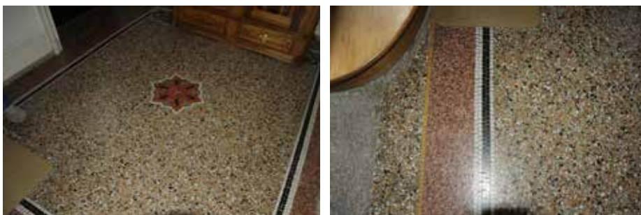
Fig. 2.240 (à gauche) Le sol en terrazzo dans une maison de maître de Porrentruy. Photo : P.-A. Borgeaud, OCC-SAP
