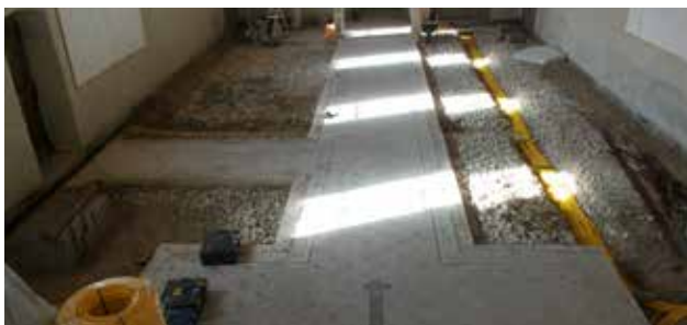
Fig. 2.234 Vermes – Église. Le sol en terrazzo avec les dalles latérales démontées et la tranchée principale pour les conduites électriques et de chauffage. Photo P.-A. Borgeaud, OCC-SAP
