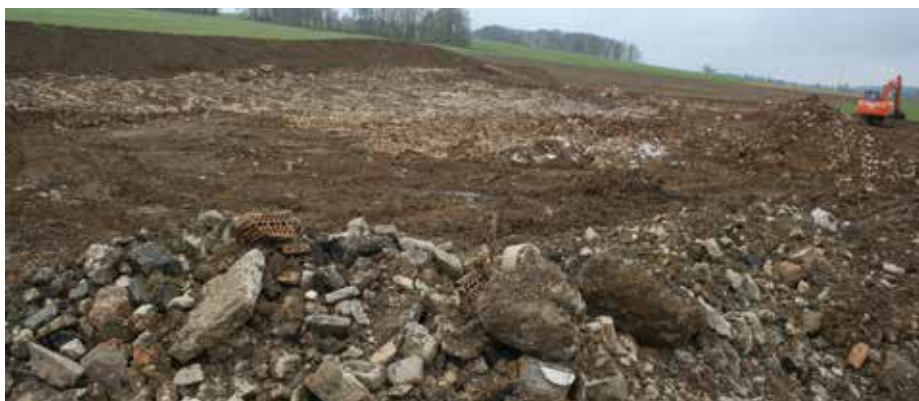
Fig. 2.154 Le Noirmont – La Calame. Le terrassement en cours vu depuis le sud-ouest avec une petite partie de la décharge au premier-plan. Photo P.-A. Borgeaud, OCC-SAP
