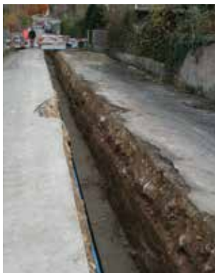
Fig. 2.175 Porrentruy – Pré Tavanne. La tranchée de canalisation vue depuis l'ouest. Photo P.-A. Borgeaud, OCC-SAP
