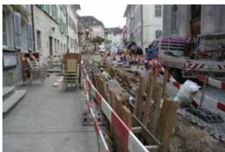
Fig. 2.193 (à gauche) Porrentruy – Annonciades, Capucins, Route de Fontenais. Les tranchées de canalisations à la rue des Annon- ciades vues depuis le nord-ouest. Photo P.-A. Borgeaud, OCC-SAP
