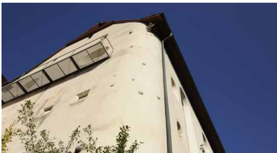
Fig. 2.186 Porrentruy – Église des Jésuites. Vue de l'angle sud-est de l'église des Jésuites où se trouvent les onze boules de pierre. Photo P.-A. Borgeaud, OCC-SAP
