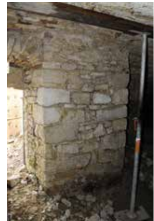
Fig. 2.326 Porrentruy – Château. Le mur pilier st. 33. Photo P.-A. Borgeaud, OCC-SAP
