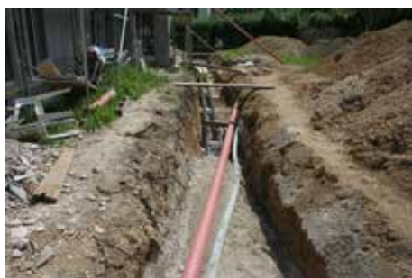
Fig. 2.203 (à gauche) Porrentruy – Annonciades, Capucins, Route de Fontenais. La tranchée de canalisation à la route de Fontenais vue depuis l'ouest. Photo P.-A. Borgeaud, OCC-SAP
