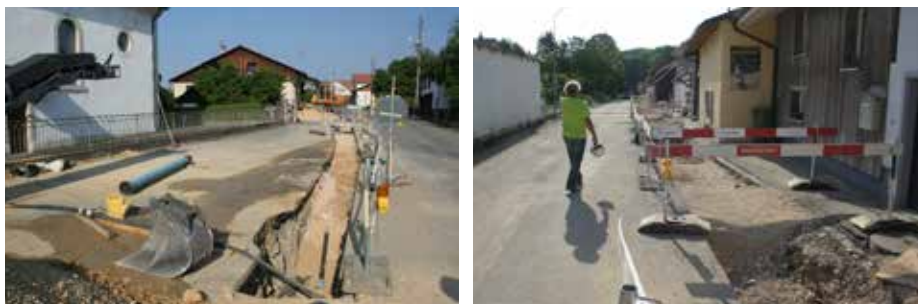
Fig. 2.156 (à gauche) Pleigne – Route des Geais. La tranchée déjà presque rebouchée devant l'église, vue depuis l'est. Photo P.-A. Borgeaud, OCC-SAP
