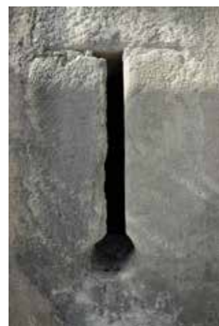
Fig. 2.320 Porrentruy – Château. La meurtrière méridionale vue depuis l'extérieur. Photo P.-A. Borgeaud, OCC-SAP
