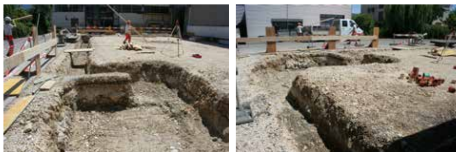
Fig. 2.139 (à gauche) Develier – rue des Romains. Tranchée de fondation vue depuis le nord, lors de notre visite du 8 juin 2017. Photo P.-A. Borgeaud, OCC-SAP
