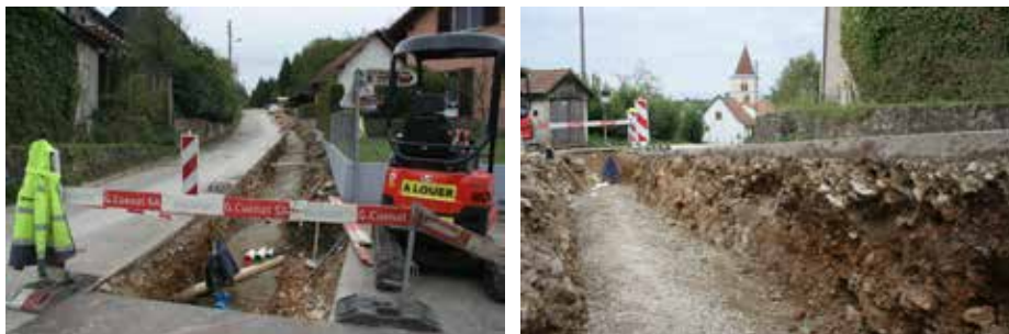
Fig. 2.79 (à droite) Coeuve – Route du Mont. Vue de la coupe dans la tranchée de la route du Mont. Photo P.-A. Borgeaud, OCC-SAP
