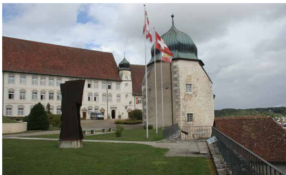
Fig. 2.245 Porrentruy – Château. La zone à excaver (surface verte sous les trois drapeaux) vue depuis le sud-ouest. Photo P.-A. Borgeaud, OCC-SAP
