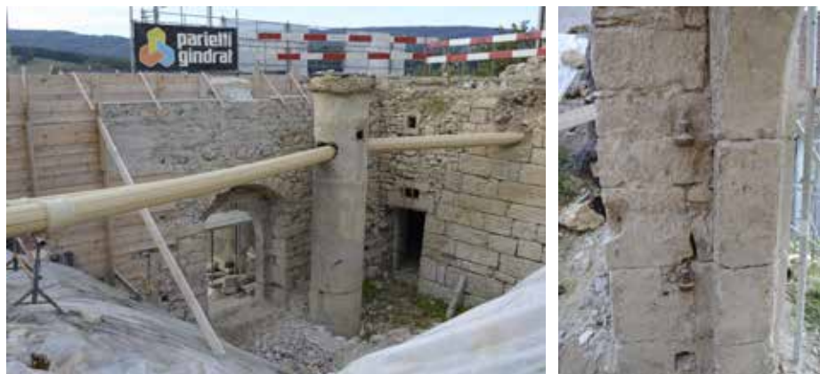
Fig. 2.332 (à droite) Porrentruy – Château. Les gonds en fer encore en place de l'ancienne porte. Photo P.-A. Borgeaud, OCC-SAP
