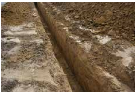
Fig. 2.6 (à gauche) Alle – Route de Miécourt. La tranchée de canalisation vue depuis l'ouest. Photo P.-A. Borgeaud, OCC-SAP
