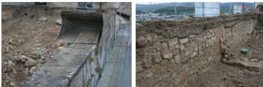
Fig. 2.270 (à gauche) Porrentruy – Château. Enlèvement des dalles de couverture du sommet du mur de soutènement st. 8.
