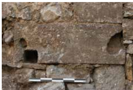
Fig. 2.301 (à gauche) Porrentruy – Château. L'extérieur de la poterne murée st. 18 vu depuis l'échafaudage. Photo P.-A. Borgeaud, OCC-SAP
