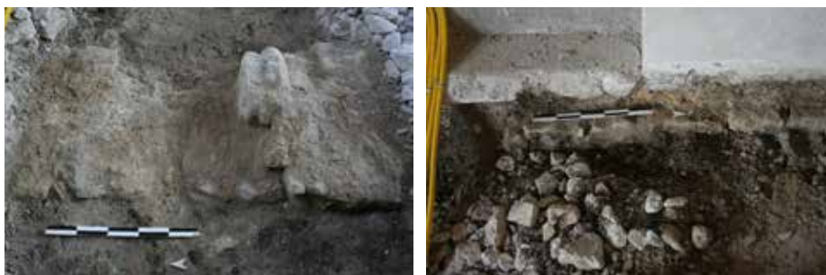
Fig. 2.238 (à droite) Vermes – Église. La fondation sous le mur ouest de la nef. Photo P.-A. Borgeaud, OCC-SAP
