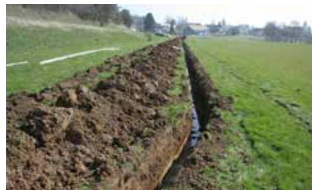
Fig. 2.37 (à gauche) Bonfol – Cras Chalet. Vue du premier tronçon fraîchement creusé à la fraise. Photo P.-A. Borgeaud, OCC-SAP
