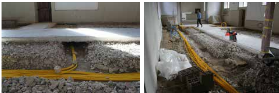
Fig. 2.235 (à gauche) Vermes – Église. Tranchée électrique et de chauffage qui traverse sous le sol en terrazzo. Photo P.-A. Borgeaud, OCC-SAP
