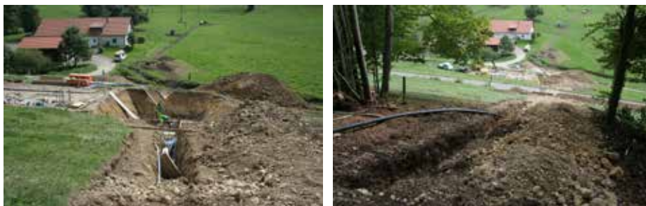
Fig. 2.163 (à gauche) Pleigne – Le Rond Pré. La tranchée et le terrassement de la grande chambre de contrôle vus depuis le nord.
