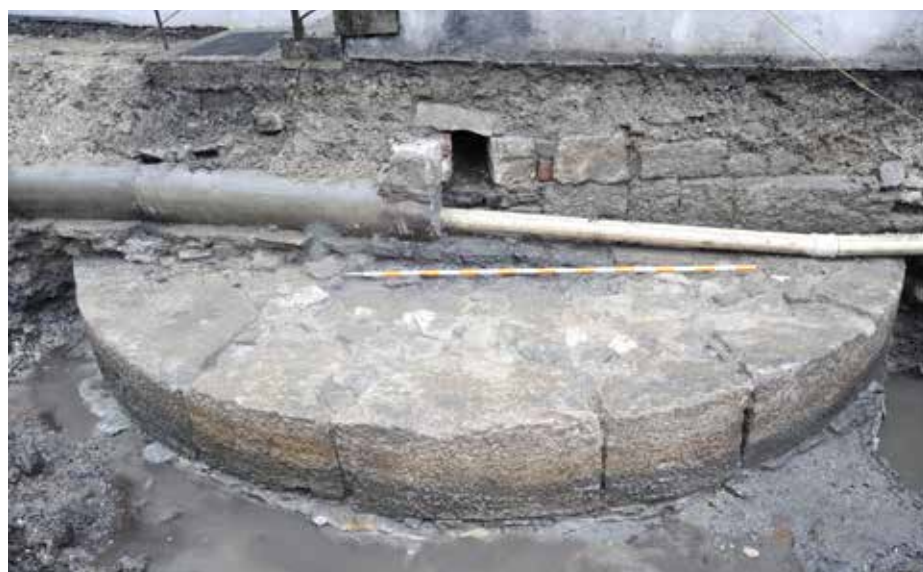
Fig. 3.3 Saint-Ursanne, Vieille Ville. Les fondations d'une tourelle du rempart ouest. Photo OCC-SAP
