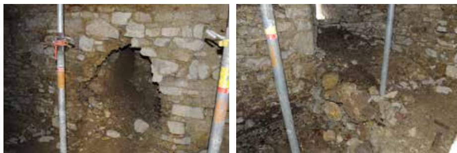
Fig. 2.316 (à gauche) Porrentruy – Château. L'échancrure st. 27 dans le mur st. 26. Photo P.-A. Borgeaud, OCC-SAP
