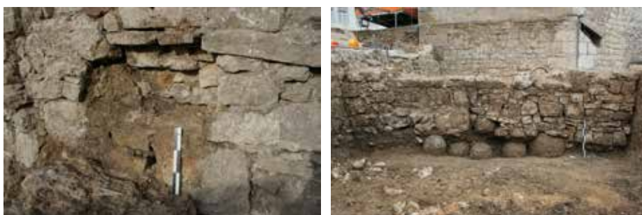
Fig. 2.267 (à droite) Porrentruy – Château. Le mur de refend st. 6 vu depuis le sud-ouest. On voit qu'il repose partiellement sur des boulets de la st. 10. On observe un boulet réutilisé dans la base de la maçonnerie (au milieu).
