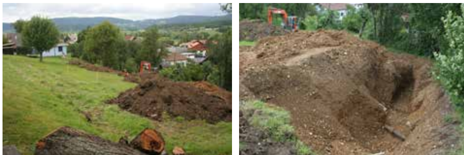
Fig. 2.47 (à gauche) Courfaivre – En Bristol. La parcelle vue depuis le sud-est au début des terrassements. Photo P.-A. Borgeaud, OCC-SAP
