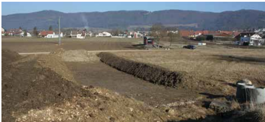
Fig. 2.243 Vicques – Le Chaufour. Le dernier tronçon décapé vu depuis le sud. Photo P.-A. Borgeaud, OCC-SAP
