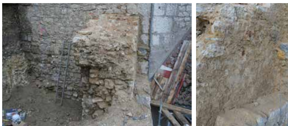
Fig. 2.263 (à droite) Porrentruy – Château. Le crépi sur la face extérieure du mur st. 5 (visible après le démontage du mur de l'esplanade st. 8). Photo P.-A. Borgeaud, OCC-SAP
