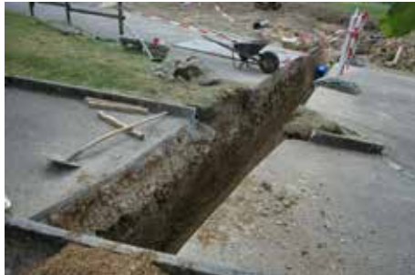
Fig. 2.72 (à gauche) Courchapoix – Es Bellieges. Vue de la tranchée sous la route de l'église (en haut) et le chemin piétonnier du cimetière (au premier-plan). Photo P.-A. Borgeaud, OCC-SAP
