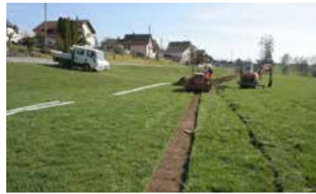
Fig. 2.35 (à gauche) Bonfol – Cras Chalet. Vue de la fraise en action. Photo P.-A. Borgeaud, OCC-SAP
