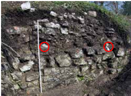
Abb. 3: Mauer Pos. 10 mit recht regelmässigen Lagen aus unterschiedlich grossen Kalksteinquadern. Die beiden Mörtelproben sind rot markiert.
