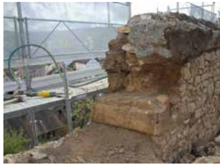
Fig. 2.272 (à gauche) Porrentruy – Château. Bloc en grès pris dans la maçonnerie du mur st. 8. Photo P.-A. Borgeaud, OCC-SAP
