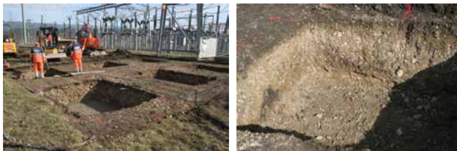
Fig. 2.25 (à gauche) Bassecourt – Entre les Vies. Vue depuis le sud-ouest d'une partie des caissons déjà partiellement bétonnés. Photo P.-A. Borgeaud, OCC-SAP
