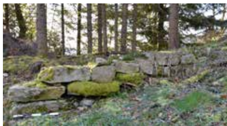
Abb. 40 Befund Nr. 20. Blickrichtung Südwesten (Foto: A. Siegenthaler /R. Berger).
