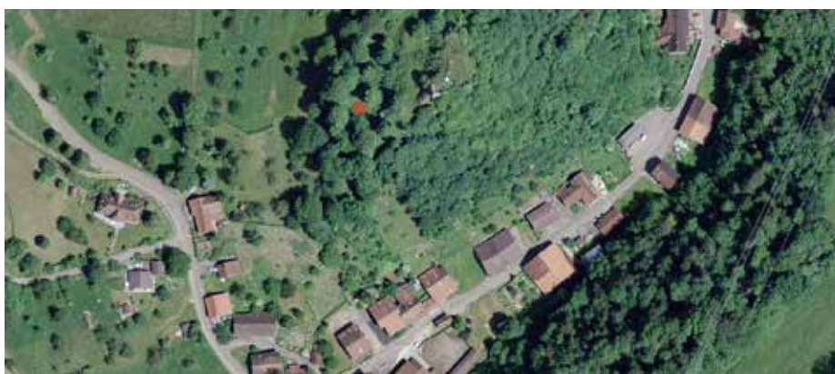
Fig. 2.11 Asuel – Château. Situation approxi- mative de la cabane WC (pastille rouge). Orthophoto tirée du GéoPortail jura.ch
