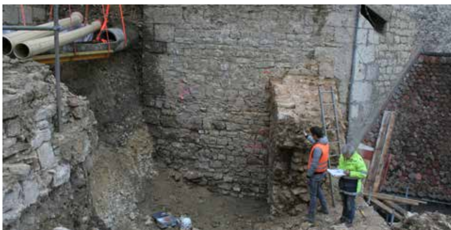
Fig. 2.278 Porrentruy – Château. Le mur de la tour du Trésor st. 9 contre lequel s'appuie le mur st. 5 (à droite). Photo P.-A. Borgeaud, OCC-SAP
