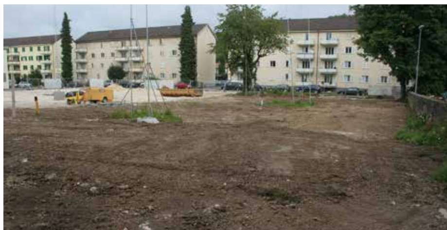
Fig. 2.179 Porrentruy – Rue du Creugenat. La zone de travaux vue depuis le sud-est. Photo P.-A. Borgeaud, OCC-SAP
