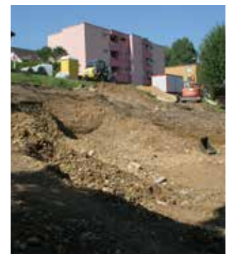
Fig. 2.49 (à droite) Courfaivre – En Bristol. Vue du terrassement en cours depuis le nord-est. Photo P.-A. Borgeaud, OCC-SAP
