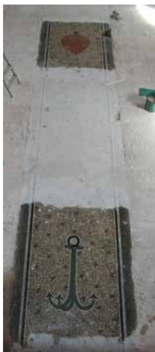
Fig. 2.217 Vermes – Église. Deux plaques du terrazzo portant des motifs de mosaïque dans l'allée centrale de la nef. Cette image illustre le gain admirable pour la vision que procure l'état humide. Le terrazzo très terne à l'état sec devient presque instantanément resplendissant et coloré en le mouillant. Photo P.-A. Borgeaud, OCC-SAP
