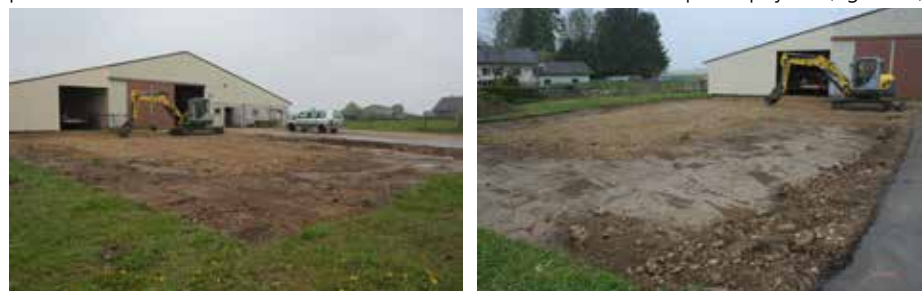
Fig. 2.59 (à gauche) Courgenay – Chemin du Pible. La surface terrassée vue depuis le sud-ouest. Photo P.-A. Borgeaud, OCC-SAP
