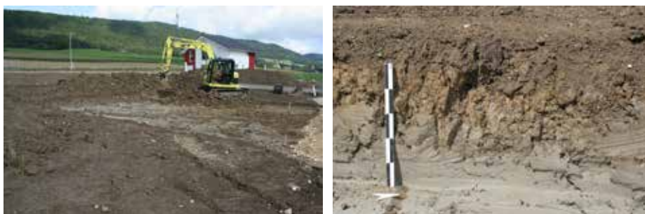
Fig. 2.148 (à droite) Glovelier – Montates. Vue de la stratigraphie locale au nord-ouest. Photo P.-A. Borgeaud, OCC-SAP
