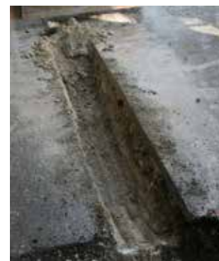
Fig. 2.145 (à gauche) Develier – rue des Romains. Vue de la petite tranchée de fondation. Photo P.-A. Borgeaud, OCC-SAP
