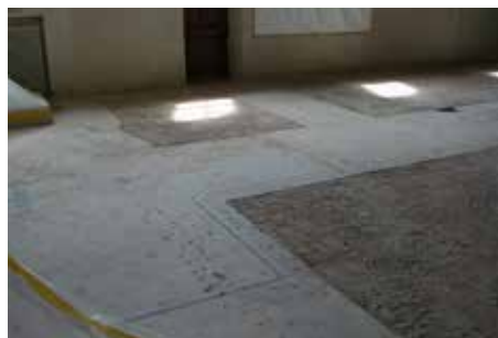
Fig. 2.214 (à gauche) Vermes – Église. La partie occidentale du terrazzo juste après son dégagement. Le sondage ayant permis son repérage avant l'enlèvement du carrelage est visible au premier plan à gauche. Photo P.-A. Borgeaud, OCC-SAP
