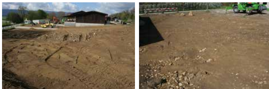
Fig. 2.181 (à gauche) Porrentruy – Sur la Combe Bruequelin. Vue du terrassement depuis le nord-est. Photo P.-A. Borgeaud, OCC-SAP
