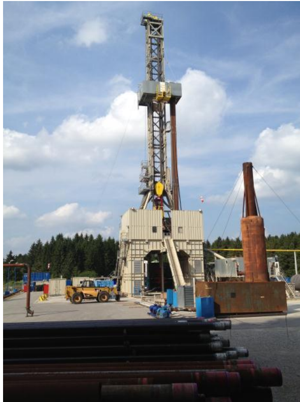
Figure 4-1 : Photo d'une installation de forage. (Source : photo CSD du site de Geretsried en Allemagne)
